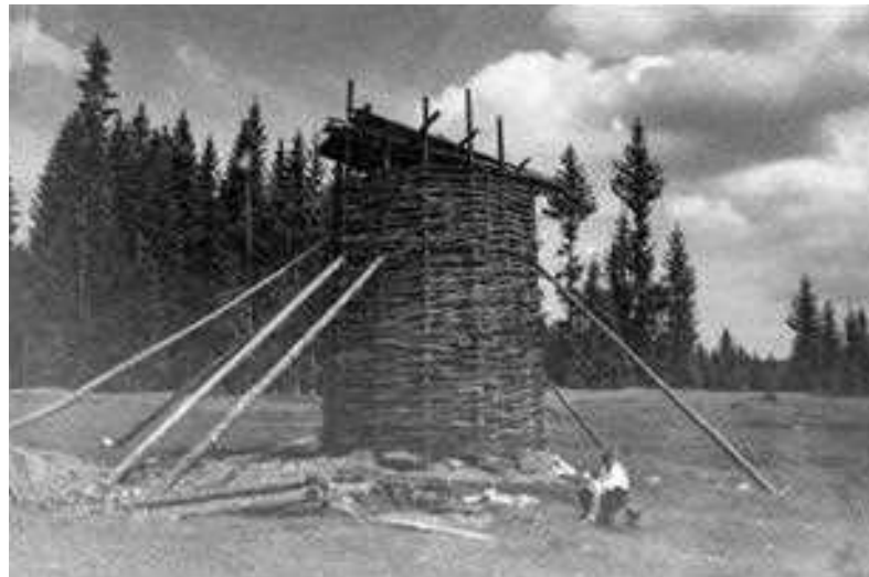
Apno se je na planinah uporabljalo tudi za vsakoletno beljenje, saj je odlično dezinfekcijsko sredstvo bivalnih, hlevskih in prostorov za predelavo mleka. Apnenica za žganje apna. Planina Goreljek (Vir: slikovni arhiv Oddelka za geografijo FF v Ljubljani)
