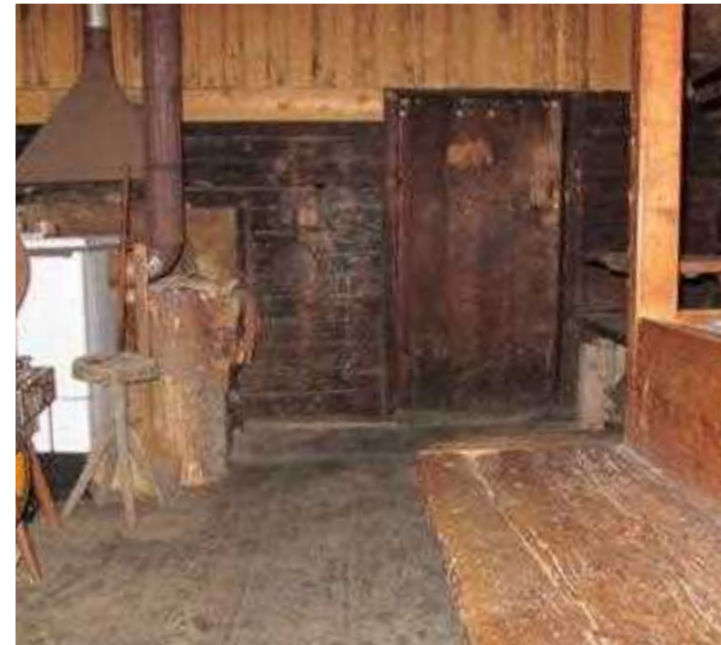
Pogled v notranjost bivalnega prostora, dvignjenega na odprto podnožje. Tlak oblikujejo široke in z oblanjem zglajene in zravnane deske. Planina Zajavornik
