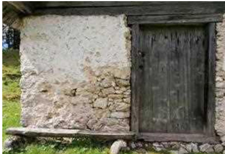
Lesen vratni okvir, vgrajen v kamnit zid, je izdelan iz tramov dimenzije 14 cm x 16 cm. Planina Vodični vrh, sirarna
