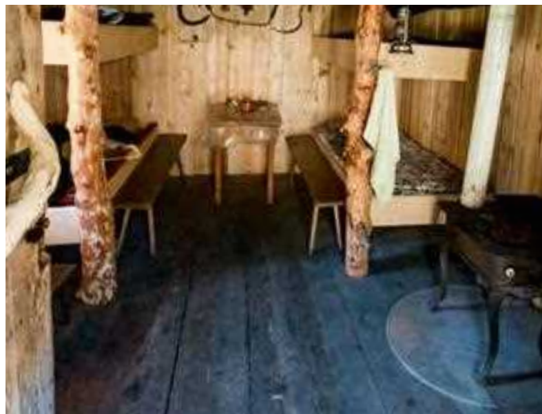
Tla v bivalnem delu pastirske stavbe so lesena, oblikujejo jih izravnani in zglajeni plohi. Tlak po videzu spominja na ladijski pod – tlak iz dolgih lesenih desk. Planina Ovčarija
