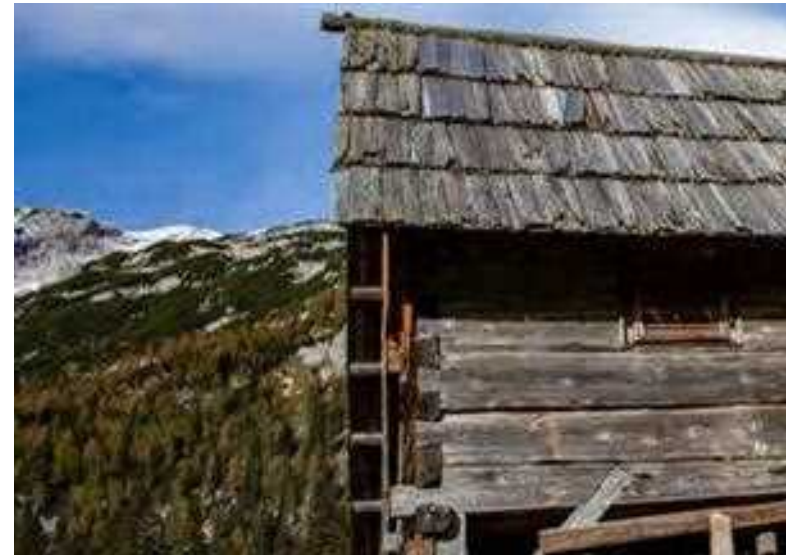
Vidna podoba vogalne zveze na roglje, posebej iz tramov izdelanih stenah, je odvisna od oblike rogljev. Stranica rogljev je lahko ravna, usločena ali kako drugače profilirana. Planina Laz
