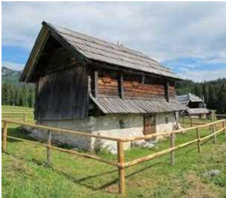
Lesen stan z zidanim podnožjem ima čelno stran lesenega masivnega ovoja, izdelan je iz štiristransko obdelanih klad, pred neugodnim vremenom – dežjem in snegom z vetrom – dodatno zaščiten z opažem iz desk v naklonu (odtekanje vode). Prav tako ima z deskami zaščitene križne vezi - čela tramov. Planina Zajavornik
