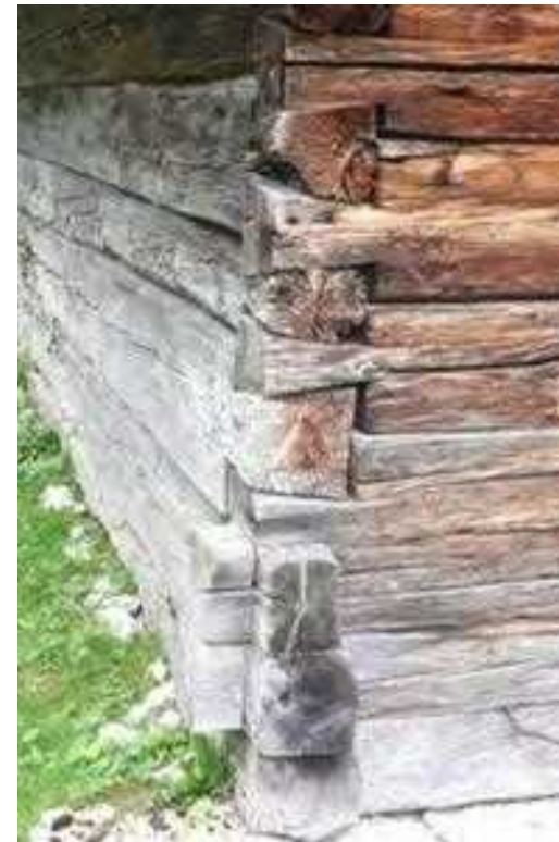
Vidna podoba vogalne zveze na roglje, posebej iz tramov izdelanih stenah, je odvisna od oblike rogljev. Stranica rogljev je lahko ravna, usločena ali kako drugače profilirana. Planina Laz
