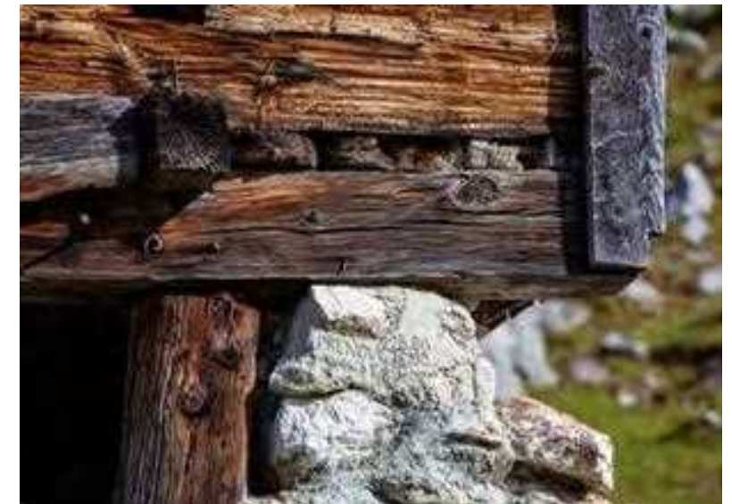
Pogleda na del zunanje stene z vidno »stropno ploščo« – na »podsek« položenimi plohi – podnicami. Planina Laz
