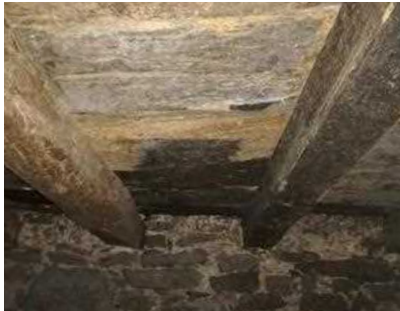
Pogled na navaden tramovni strop – konstrukcija je vidna.
