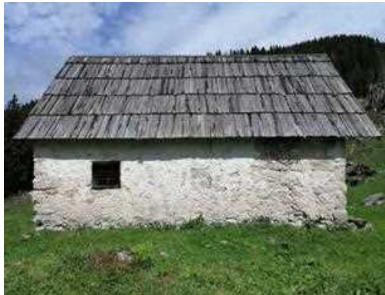
Osnovna značilnost lesene kritine je siva barva in površinsko razmeroma majhna razčlenjenost, ki je določena s širino in dolžino skodel. Planina Vodični vrh , sirarna
