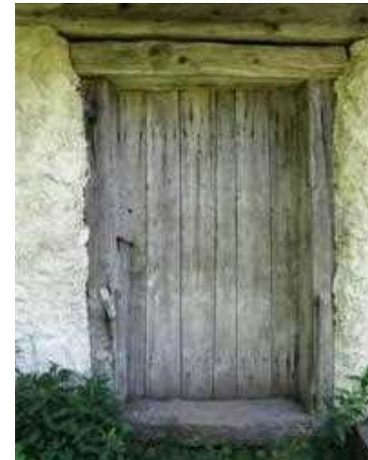
Zagotovo vsa v pastirskih naseljih ohranjena vratna krila zrcalijo ukoreninjeno tradicijo izdelave mizarskih vedenj in znanj, ki so se skozi stoletja prenašala iz roda v rod. »Vsaj za 16. stoletje lahko domnevamo v kmečki rabi troje vrst vrat: gladka vrata iz desk, ki so na notranji strani vezana z dvema prečnima in verjetno eno prekotno letvijo; z letvami na zunanji strani podvojena vrata in morda vrata iz desk z zunanjim pribitim okvirjem. (Vir: Makarovič, 1981, str. 21) Planina Zajamniki, Planina Ovcarija, Planina Dedno polje
