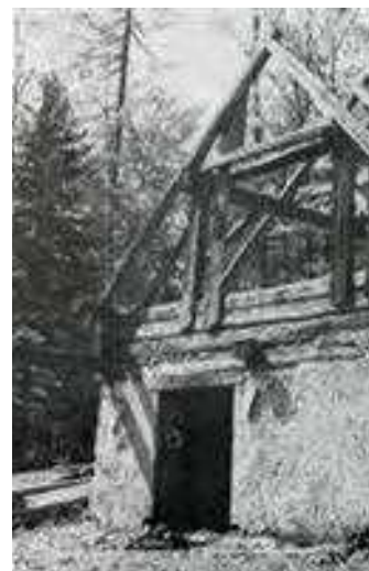
Konstrukcija ostrešja »na stol« z dodanimi in podprtimi vmesnimi legami. (vir: Cevc, 1984, str. 101)
