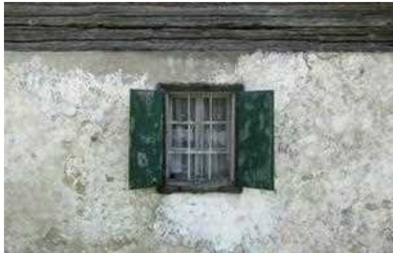
Zastekljena okenska krila so izdelana iz preprostih lesenih okvirjev, ki so zaradi uporabe majhnih kosov šip členjeni s prečkami. Prevladuje členitev enega ali dveh okenskih kril na štiri ali na šest kvadratnih ali pravokotnih pol. Koprivnik
