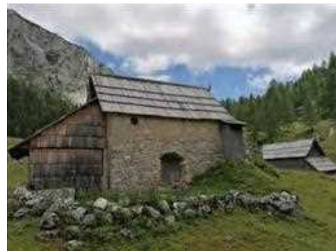
Kamnito podnožje ali podstavek, zgrajeno iz neobdelanega in grobo obdelanega naravnega kamna, se nadaljuje v kamniti zid. Planina Laz, stan
