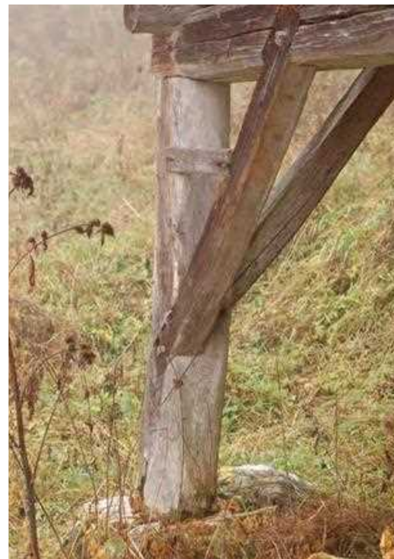
Kobila je »poldrugi meter visok lesen steber s kamnitim podstavkom, sestavni del ogrodja pastirske kočice (Bohinj)«. (Slovenski etnološki leksikon, 2011, str. 220) Planina Grintovica, stan
