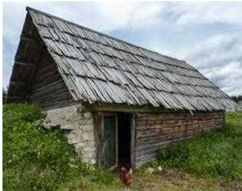
Lesen stavbni ovoj je izdelan iz lesenih plohov, ki so v vogalih vpeti v pokončne stebre. Konstrukcija je izjemna. Planina Zajavornik, hlev
