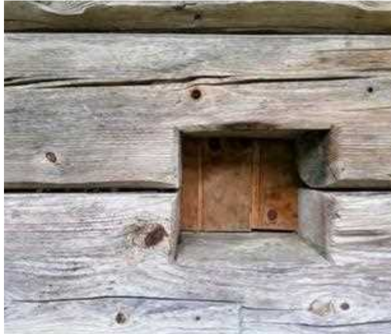
Najstarejše zastiranje (okenska krila) so pomične deske, ki se zapirajo z drsenjem po utoru letvice, pritrjene na na ostenje - okno »na smuk«. Planina Vodični vrh
