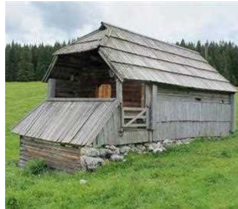
Vzdolžno leseno masivno steno, izdelana je iz vodoravno naloženih tramov, ščiti opaž, ki je izdelan iz krajših desk, ki so na (pod)konstrukcijo pritrjene s prekrivanjem – odtekanje vode. Planina Zajavornik
