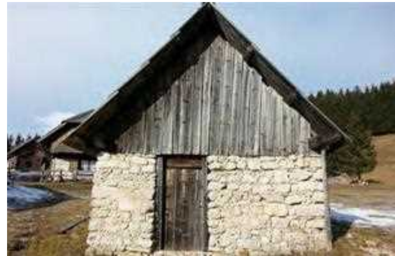
Zagotovo vsa v pastirskih naseljih ohranjena vratna krila zrcalijo ukoreninjeno tradicijo izdelave mizarskih vedenj in znanj, ki so se skozi stoletja prenašala iz roda v rod. »Vsaj za 16. stoletje lahko domnevamo v kmečki rabi troje vrst vrat: gladka vrata iz desk, ki so na notranji strani vezana z dvema prečnima in verjetno eno prekotno letvijo; z letvami na zunanji strani podvojena vrata in morda vrata iz desk z zunanjim pribitim okvirjem. (Vir: Makarovič, 1981, str. 21) Planina Zajamniki, Planina Ovcarija, Planina Dedno polje
