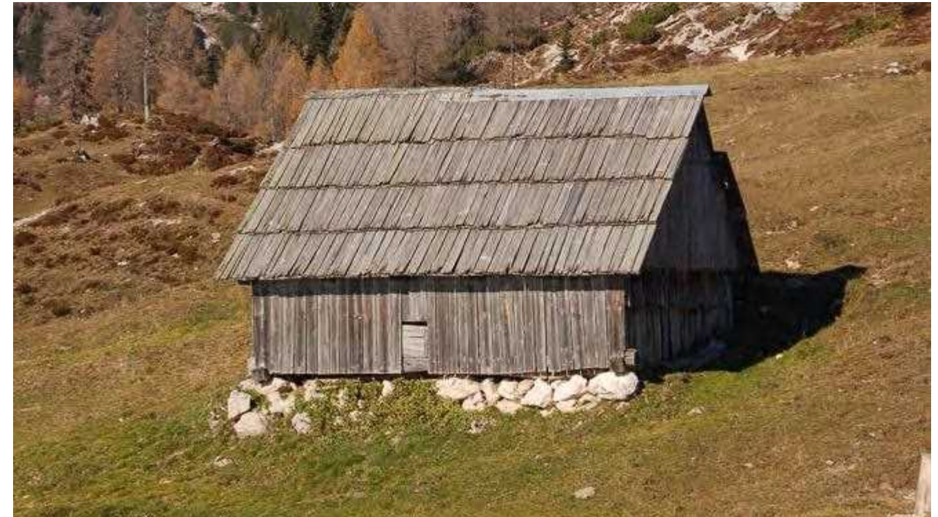
Primer kamnitega podstavka z leseno nadgradnjo. Planina Krstenica
