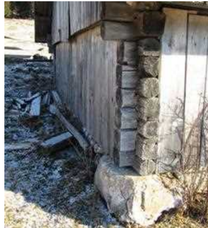
Podstavek leseni konstrukciji je bila pogosto kar raščena skala – trda in kompaktna kamnina iz apnenca, dolomita ali dolomitnega apnenca. Planina Zajamniki, hlev
