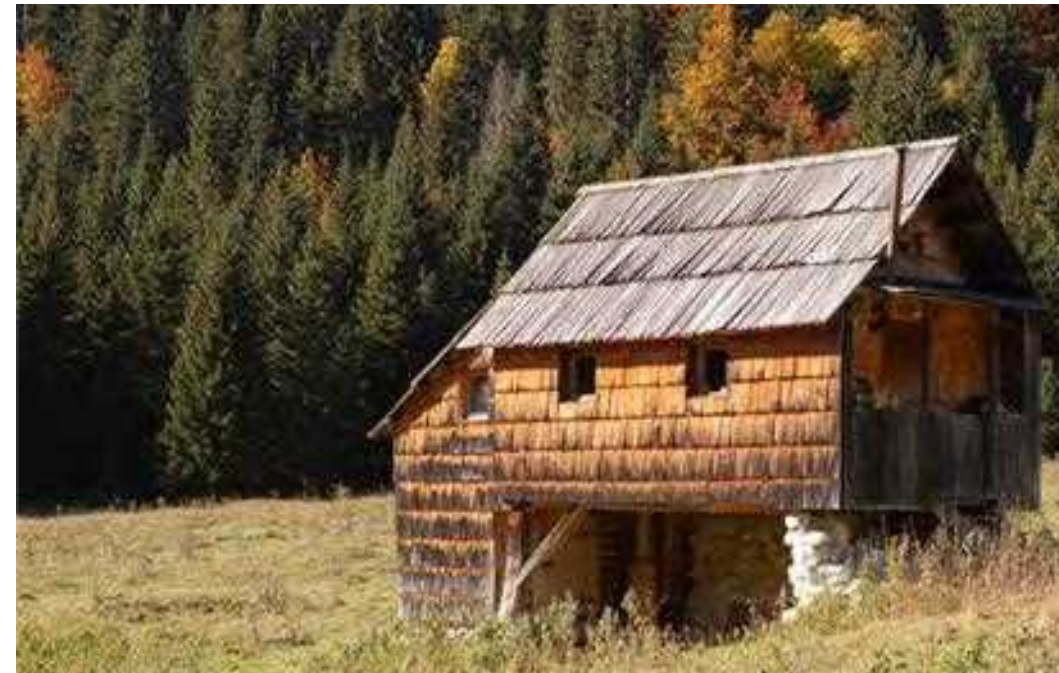
Stavbe v planinskih naseljih so eno- ali dvoetažne, odvisno od tega ali so pritlične ali vrhhlevne – s podnožjem, ki se po višini prilagaja razgibanemu terenu. Planina Blato
