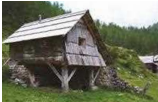
Podstavek sestavljen iz kamnitega zidu in dveh lesenih "kobil". Planina Vodični vrh – Ukčov stan (Vir: Cevc, 1984, str. 239)
