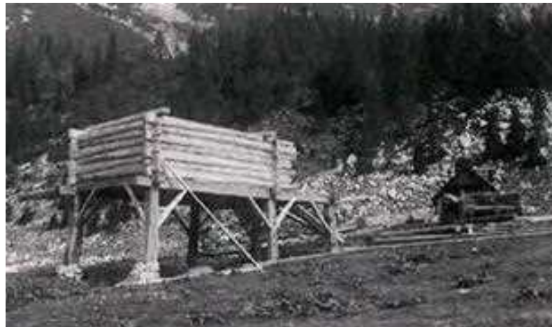
Pastirski stan na lesenem podnožju, na šestih lesenih »kobilah«. »Pastirski stan v bohinjskih planinah so gradili najmanj po štirje možje; kočjo so postavili v približno enem mesecu, če so morali posekati tudi les«. Planina Laz, stan (Vir: Cevc, 1984, str. 46)
