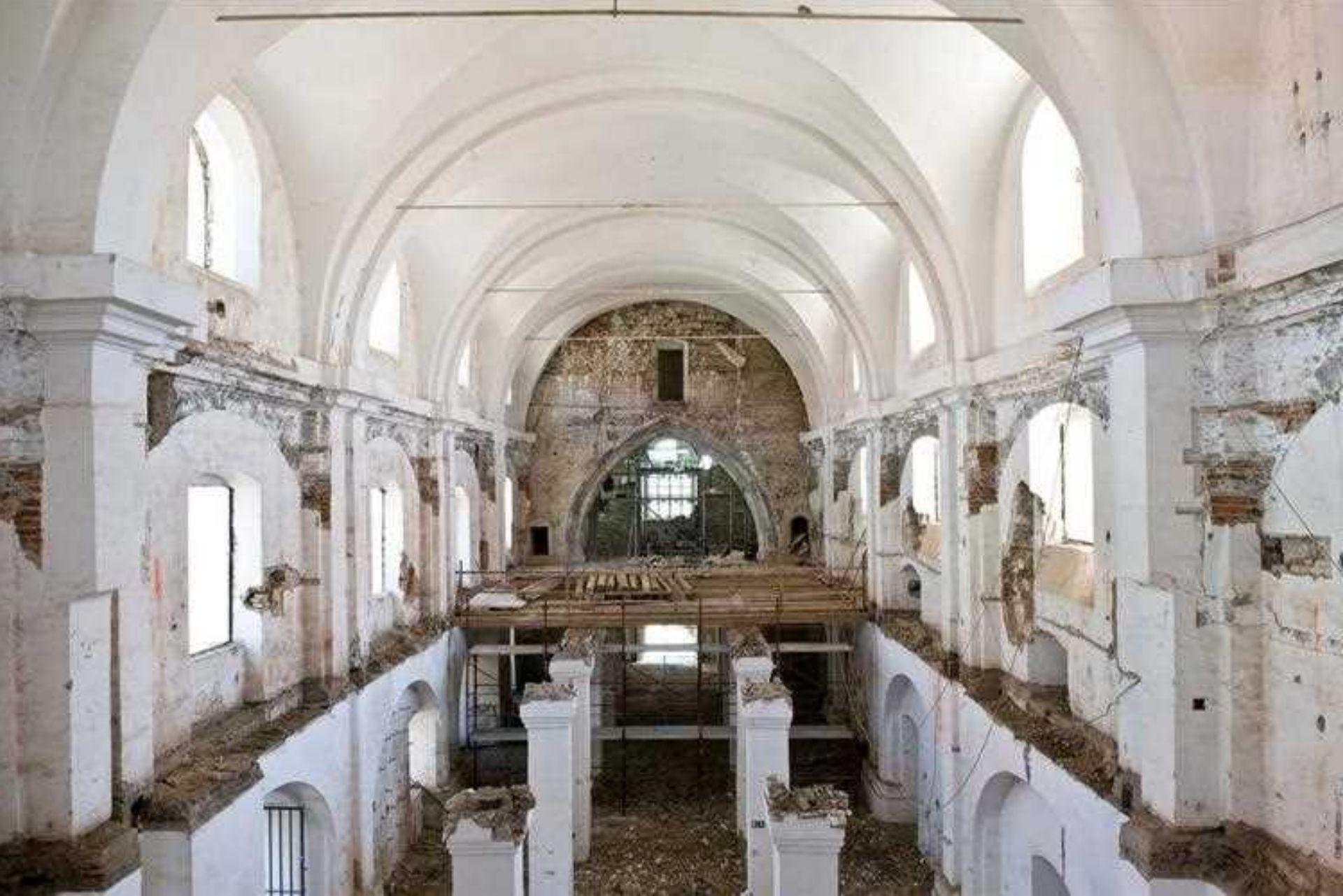
Notranjščina cerkve proti vzhodu: stanje med odstranitvijo etažne konstrukcije
