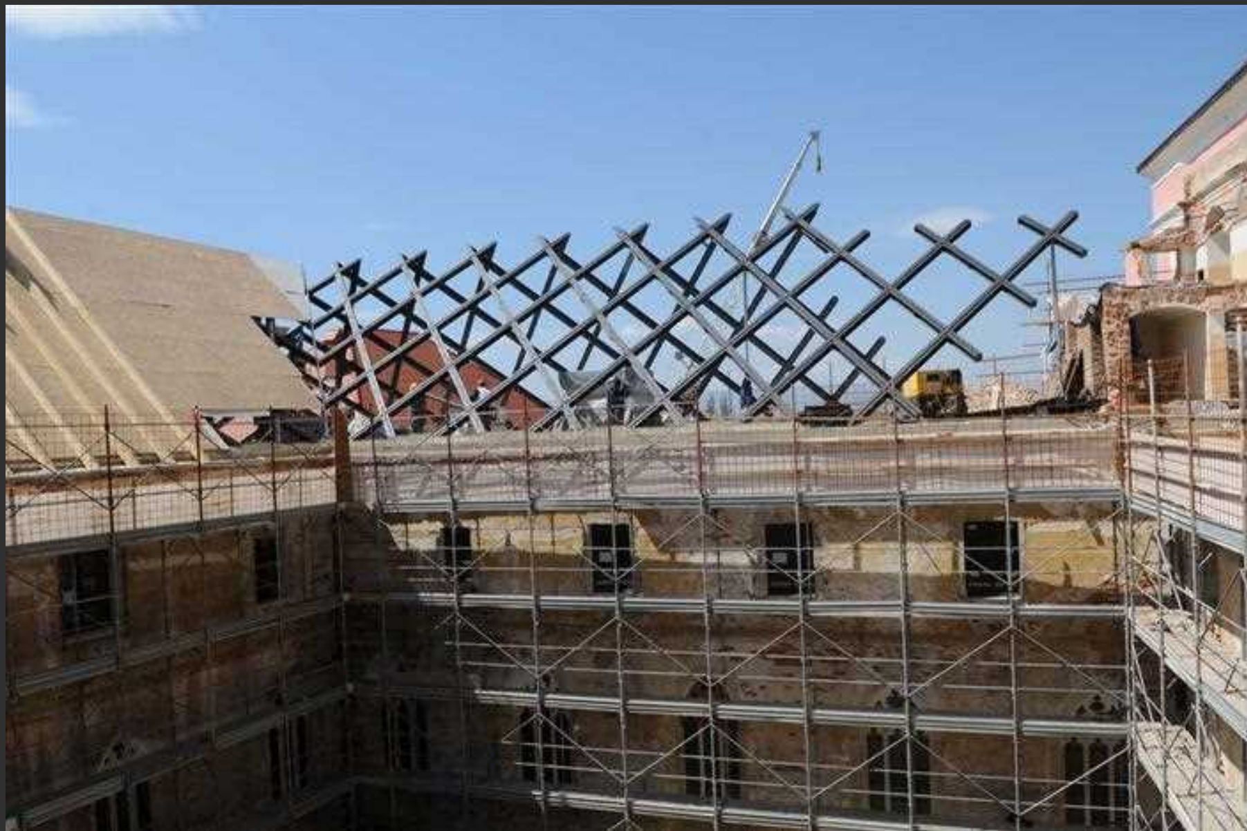
Streha zahodnega samostanskega trakta med izvedbo 2. faze prenove
