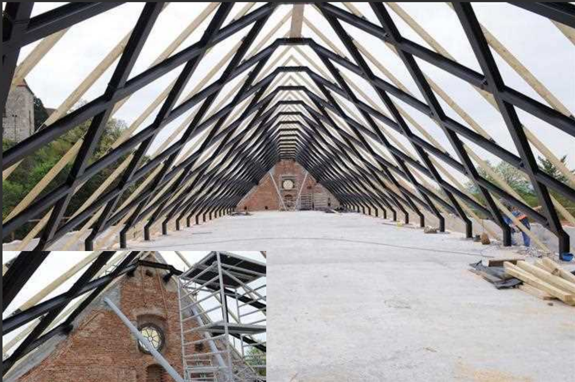
Nova strešna konstrukcija in statična utrditev vzhodnega pročelja
