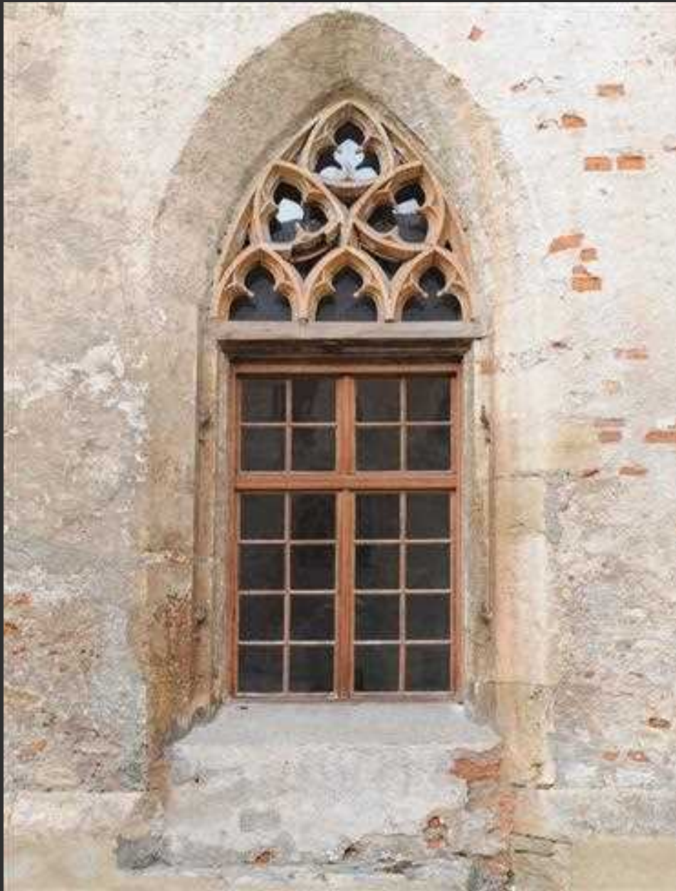
Okno z originalnim opečnim krogovičjem pred in po posegu
