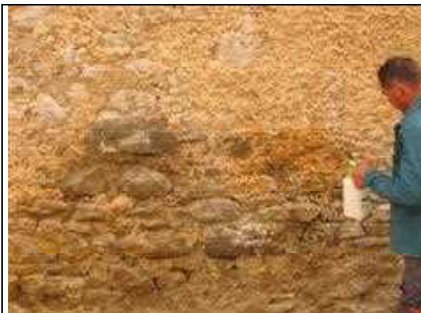
Vlaženje zidu pred ometavanjem. Apneni omet nanašamo vedno na mokro podlago.
