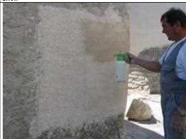
Omet negujemo – vlažimo med sušenjem.
