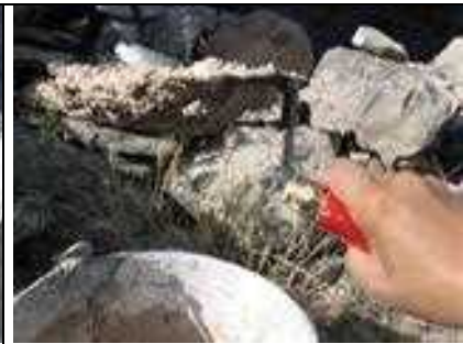
Malta mora biti tako mastna, da obstane na obrnjeni žlici.
