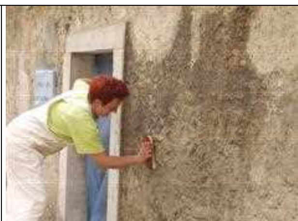
Omet in zid očistimo prahu in nečistoč s ščetkanjem, ometavanjem, blagim vodnim curkom itd.
