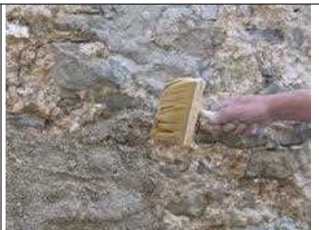
Vlaženje zidu pred ometavanjem
