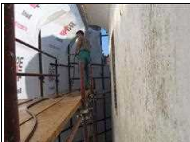
Zaščita odrov z juto in vlaženje, ki ustvarja primerno mikroklimo
