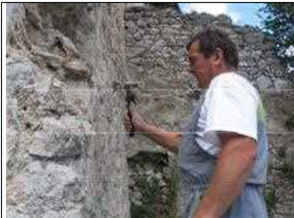
Čiščenje cementnih dodatkov
