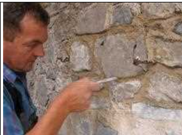
Z modelirko napraskamo površino in očistimo robove kamnov.
