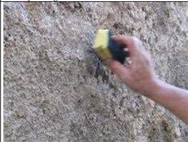
Povdaranje vidnih kamnov- čiščenje odvečne malte
