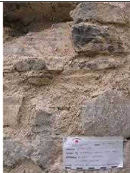
Vzorec popravila kamnitega zidu
