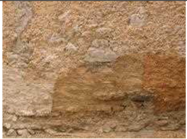
Vzorec treh različnih barv ometov.
