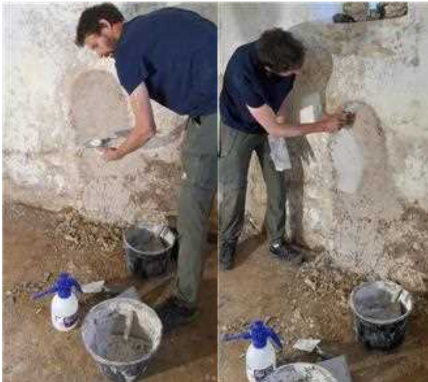
Slika 10: Nanašanje fine apnene malte na že nanešen grobi omet
