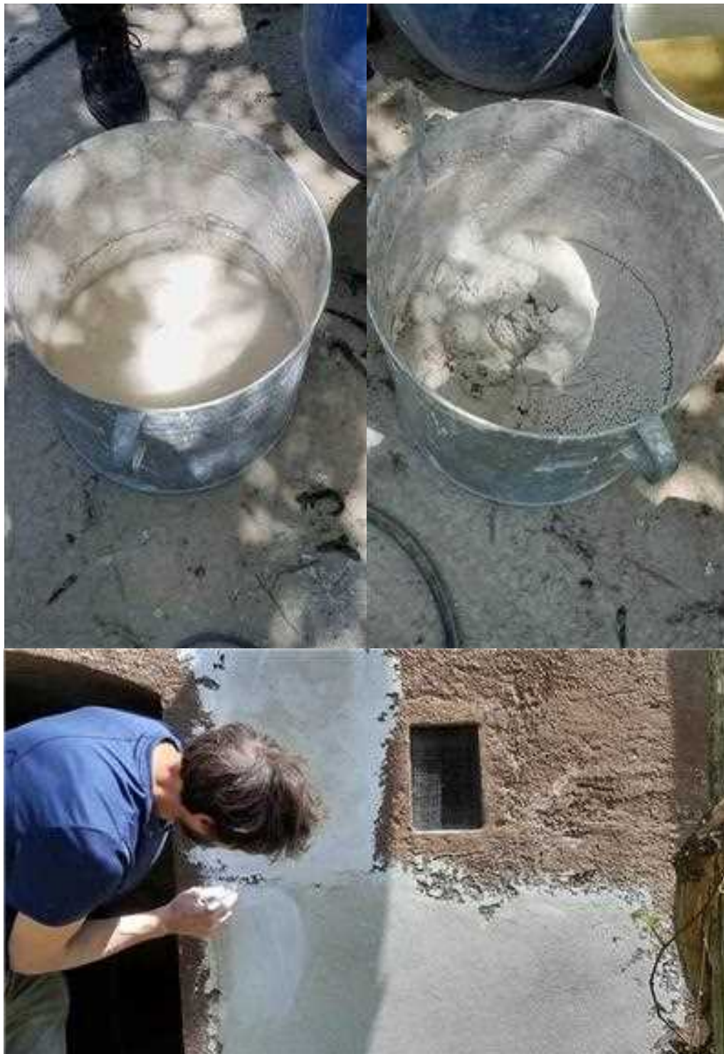
Slika 12: gašenje žganega apna za izdelavo apnenega opleska, pleskanje s čopičem
