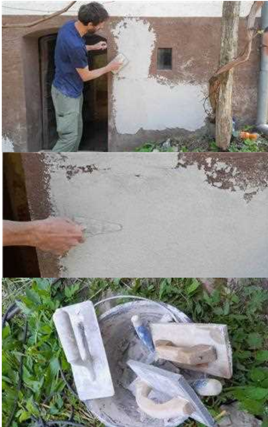
Slika 11: zaribavanje, dodatno likanje in orodje pri nanašanju fine apnene malte
