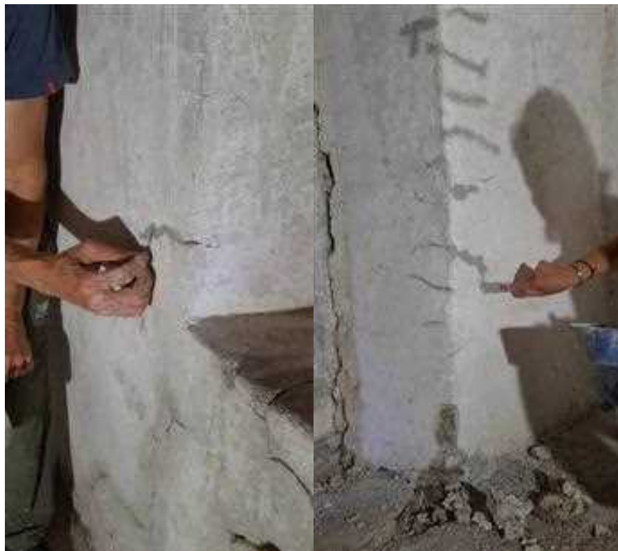
Slika 8: zaplnjevanje bolj grobih razpok v ometu
