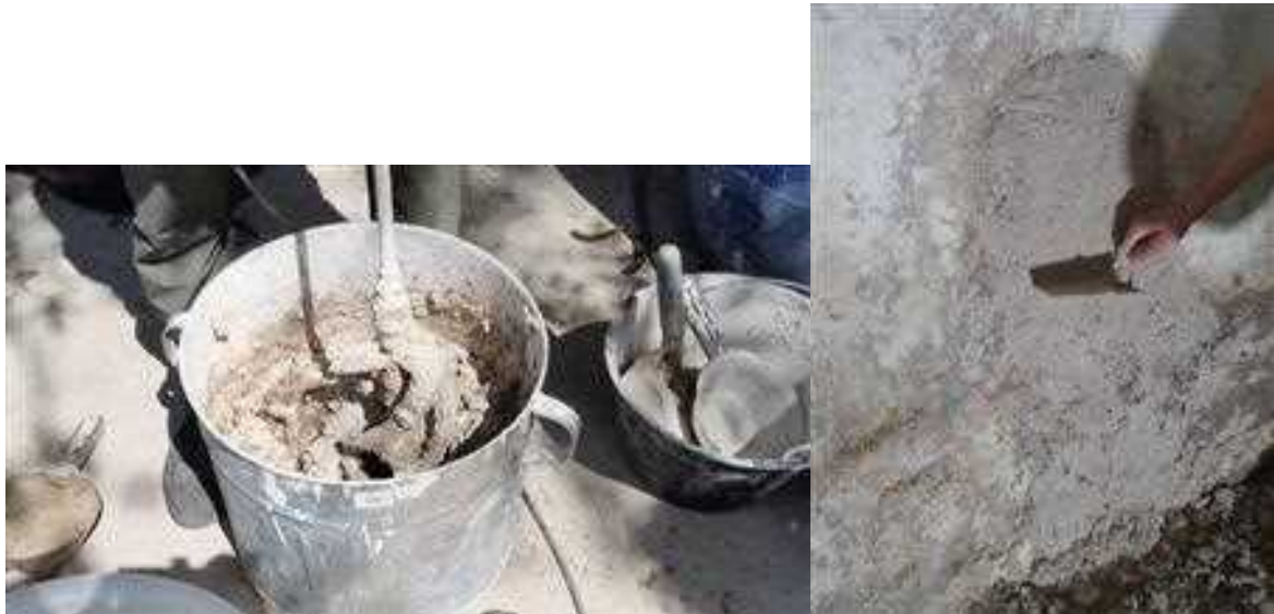
Slika 1: Priprava grobe vroče apnene malte (žgano apno smo 20 minut gasili v pesku, nato pa zamešali s strojnim mešalnikom) in nanašanje na stene kleti kašče
