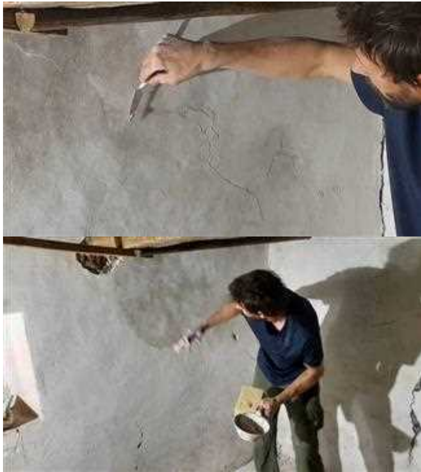
Slika 7: zaplnjevanje najbolj finih razpok v ometu
