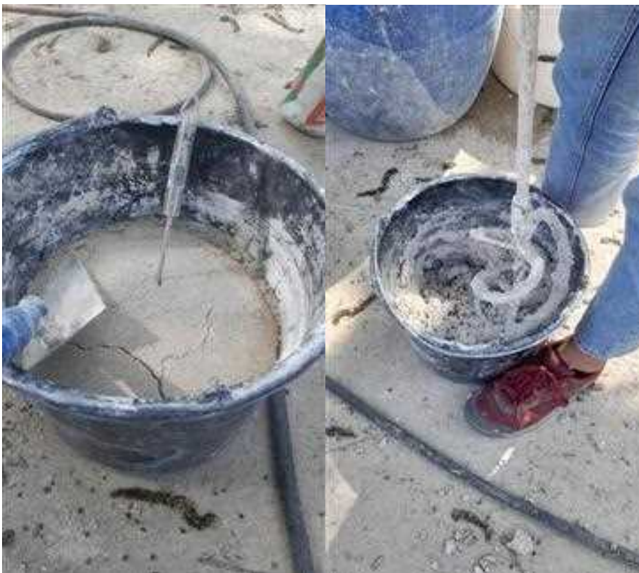
Slika 5: Priprava vroče fine apnene malte
