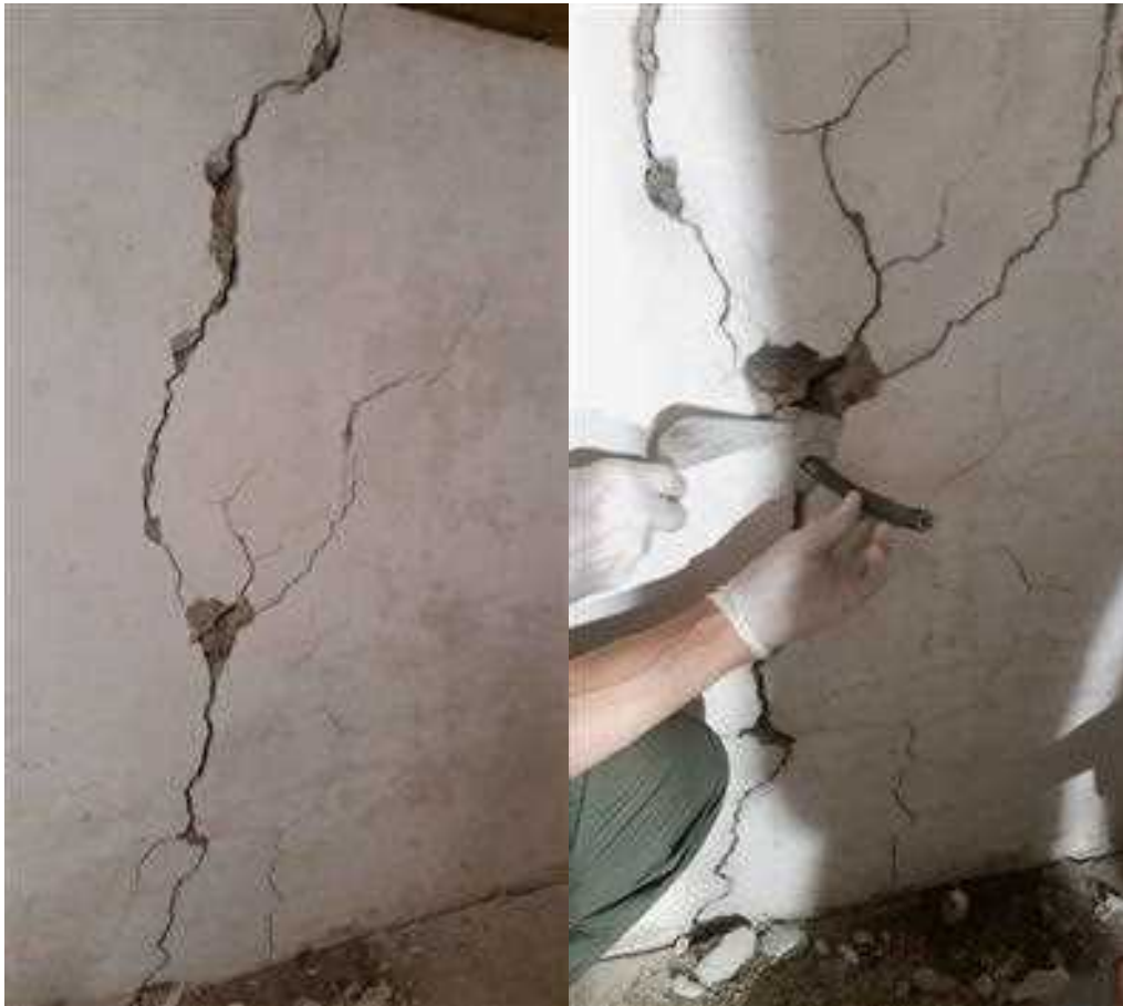
Slika 9: Injektiranje najbolj grobih razpok v ometu in zidu
