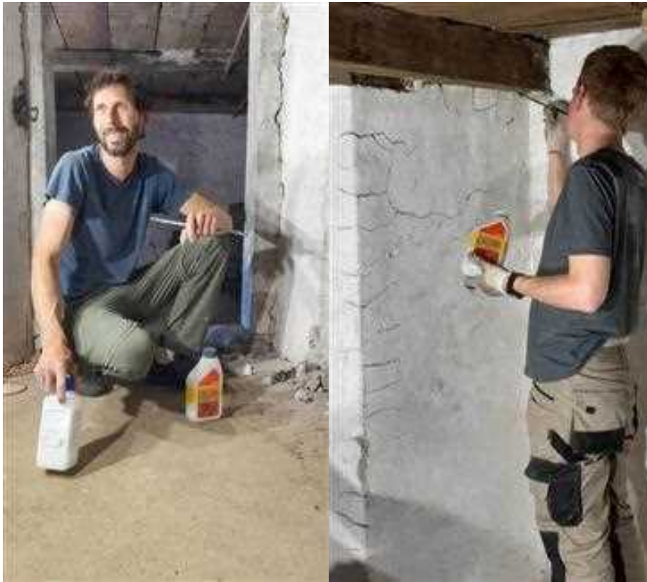
Slika 4: utrjevanje razpok s Kalosilom
