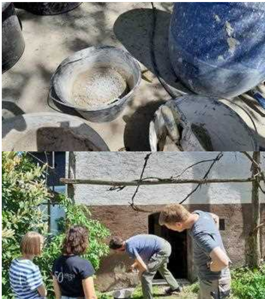
Slika 2: Priprava in nanos grobe vroče apnene malte na zunanje stene kašče
