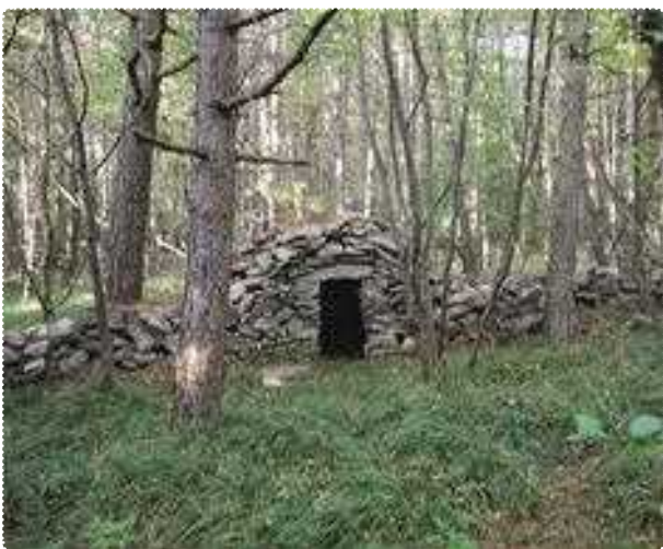
[33] Remonova hiška na Liscu pri Lokvi je vezana v nizkem zidu. Hiška je zidana na klasičen način z lepo vezanimi kamni ob stranicah vhoda, gurencem in visoko obokano streho v kupolo. F.: B. Čok
