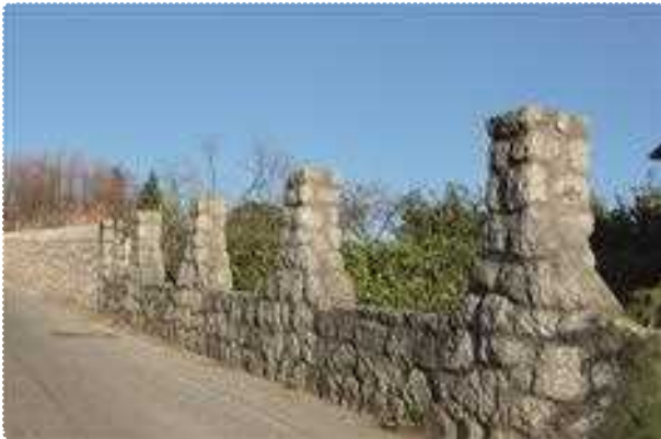
[54] Zid je zidan s kamenjem iz bližnjega opuščenega kamnoloma, vendar z malto, s kamni, ki »ne ležijo«, in v obliki, ki nima nič skupnega s suhim kraškim zidom. F.: E. Belingar
