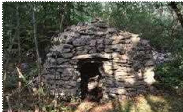
[30] Samostojna Jurčkova hiška na Mravah pri Lokvi je nekaj posebnega. Na zunaj je peterokotne oblike, znotraj pa kvadrataste z lepo velbano streho. Vhod je koničen in ima poleg gurenca še kap. Zgradil jo je pastir Jože Čok, po domače Pepi Jurčkov iz Lokve, in je ena od njegovih dvanajstih hišk, ki mu jih pripisujejo. F.: B. Čok
