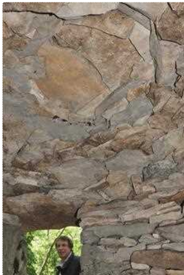
[43] Srednje visoki obok, zidan po načelu visokega. Razdalja od jrte do vrha strehe je krajša kot pri visokem oboku. F.: B. Čok
