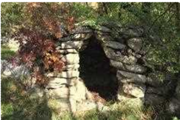
[45] Previsevanje obeh zidov v streho. F.: B. Čok
