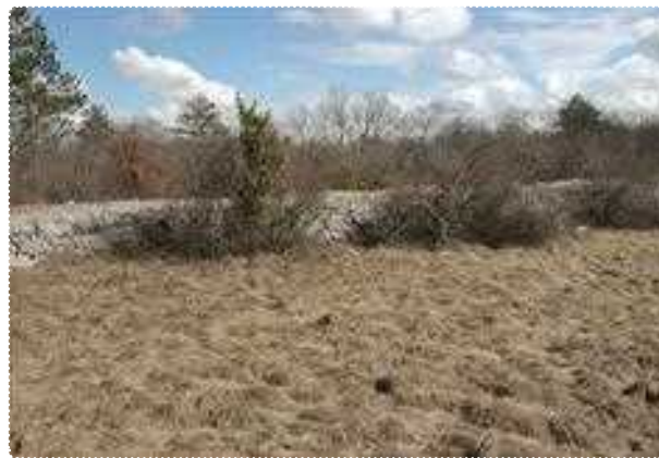
[18] Tupelče, Železniški nasip proge ozkotirne železnice. F.: E. Belingar
