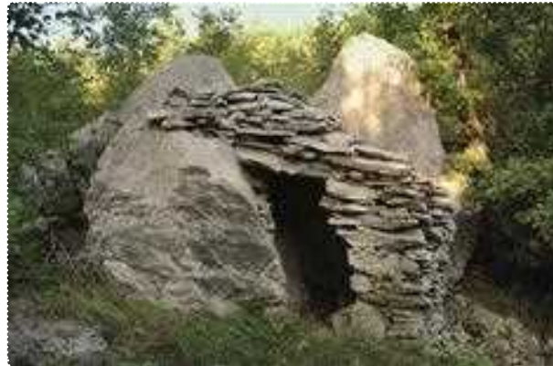
[41] Streha z nagnjenimi skrlami in delnim obokom. F.: B. Čok
