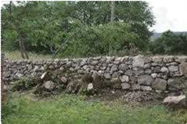
[47] Požagano drevje ob zidu ograde bo podaljšalo življenjsko dobo suhe gradnje. F.: B. Čok
