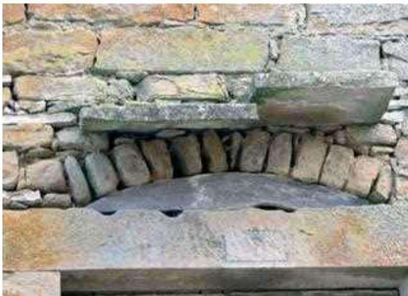
Foto 45: Kamnit nadstrešek nad vhodnimi vrati v Topolovcu
