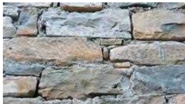
Foto 52: Šmarje, primer solidne obnove kamnitega zida
