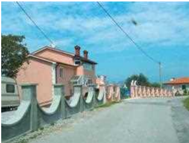
Foto 8: Novogradnja pred Borštom
