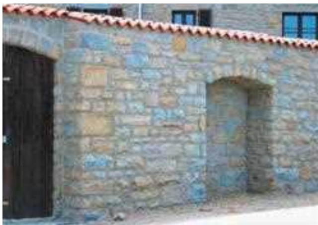
Foto 49: Gradnja dvoriščnega zidu z debelimi cementnimi fugami
