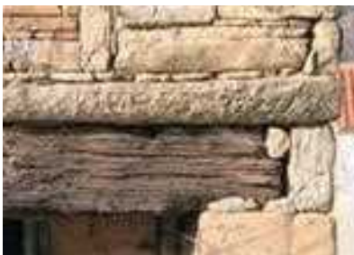
Foto 39: Kamnita podpora razbremenilne preklade
