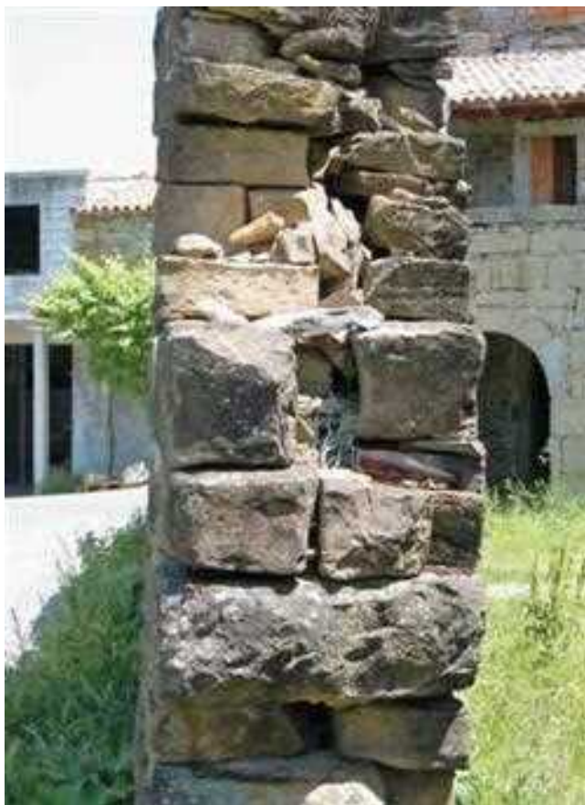
Foto 30 in 31: Prerez zida in hišni vogal v Topolovcu
