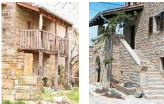
Foto 101: Obnovljen gank v Laborju
