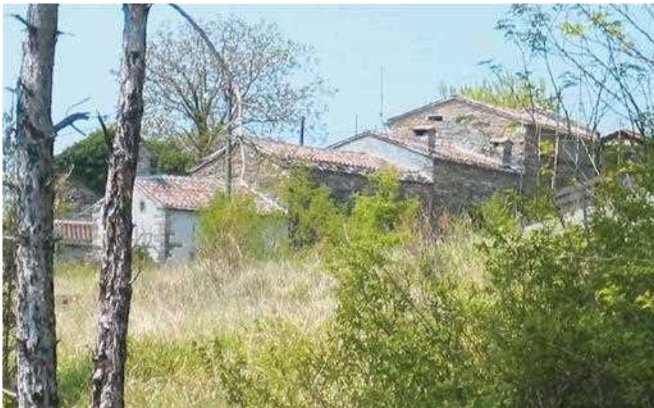
Foto 25: Primer pravilne obnove v Pisarih
