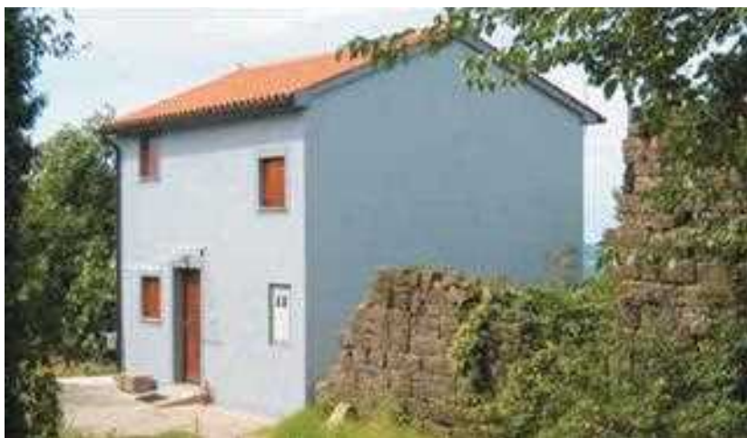
Foto 46: Obnovljena hiša v Topolovcu
