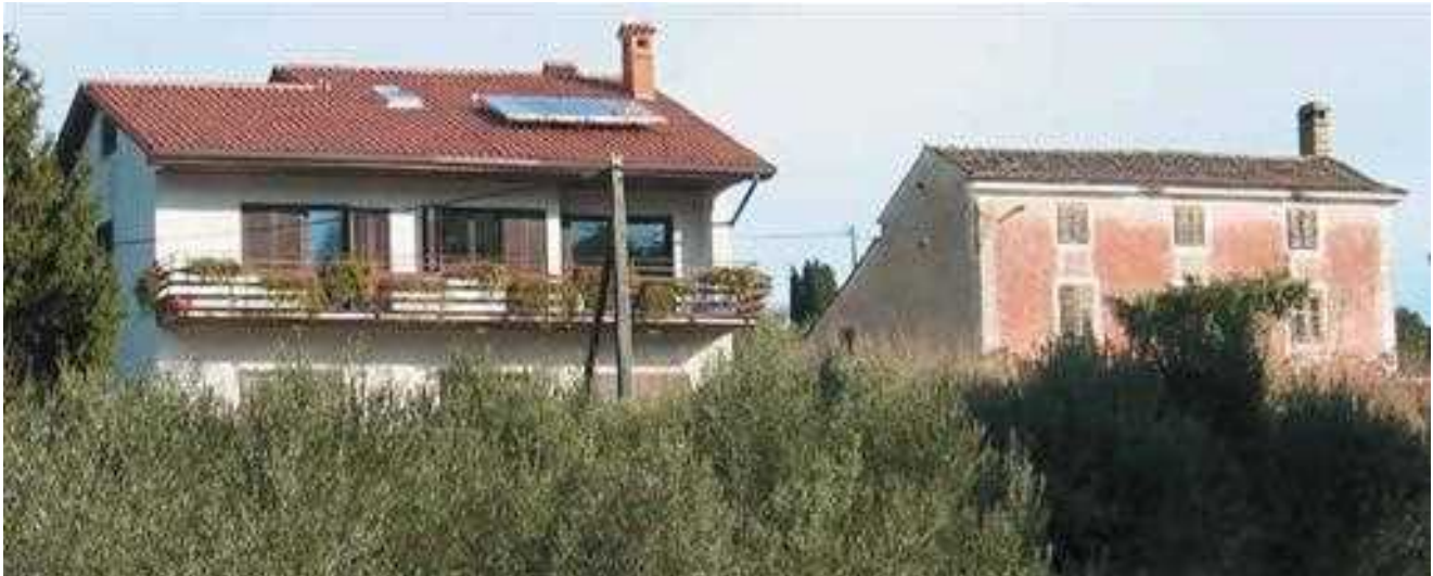
Foto 21: Stara in nova hiša v Strunjanu: primerjava kaže, kako se nova gradnja ne ozira na lokalne značilnosti: glavna fasada, »obraz« hiše, ki pri stari hiši ponosno gleda proti cesti, je pri novi hiši izmaličen s prevelikim napuščem, balkonom in predimenzioniranimi fasadnimi odprtinami.
