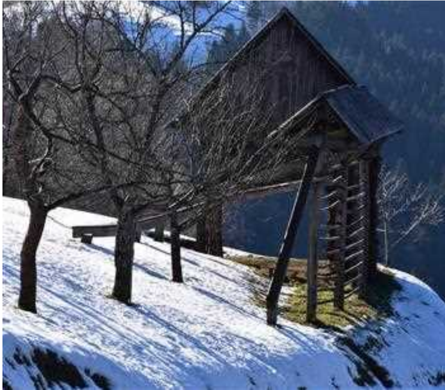
Slika 7: Primer tradicionalnega enojnega kozolca v vasi Podlanišče, v obliki podaljška k toplarju, foto Uroš Gantar
