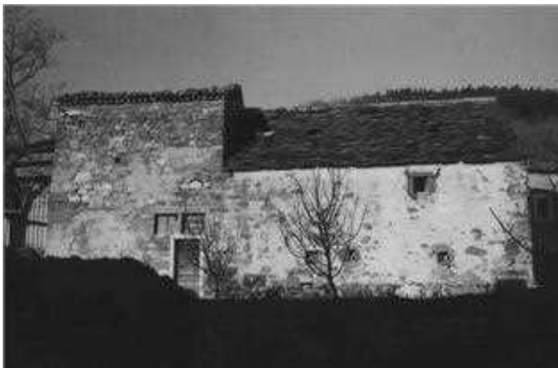
Slika 6 Štefkova štala v Hraščah pri Podnanosu. Njeno streho iz sivega flišnega peščenjaka so začeli obnavljati v letu 2005.
