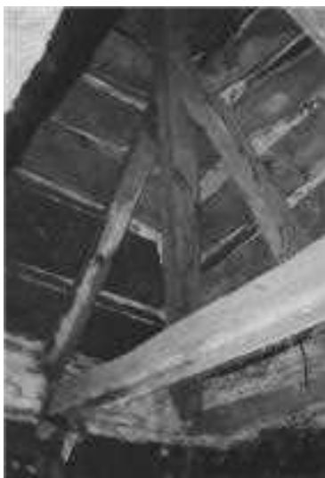
Slika 12 Pri trikapni strehi hiše Adamkinih v Kazljah leži na zidu pod tretjim kapom pozidnica. Nanjo se opirata robnik in desni presečnik.
