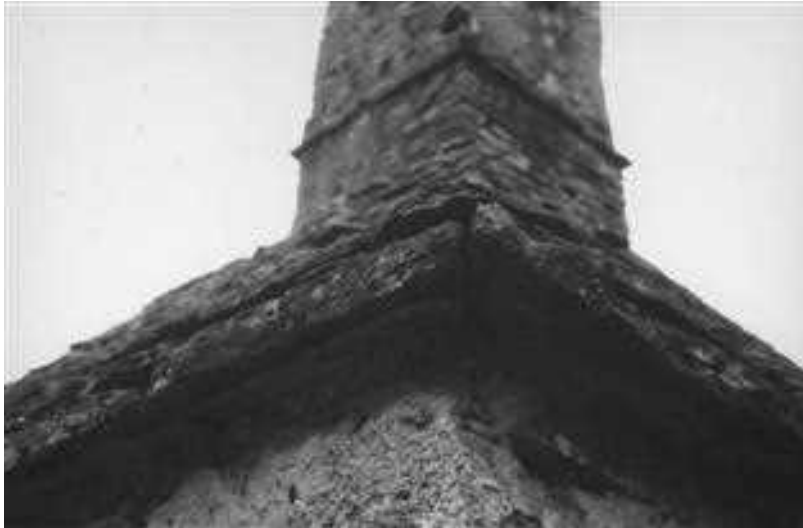
Slika 31 V grebenu strehe na spahnjenici pri Šobčevih na Kalu si v plasteh izmenoma sledijo pari polovičnih grebenjakov in celi grebenjaki. V špranje med plastmi grebenjakov so potaknjene tenke skrilice, da greben ne zija.
