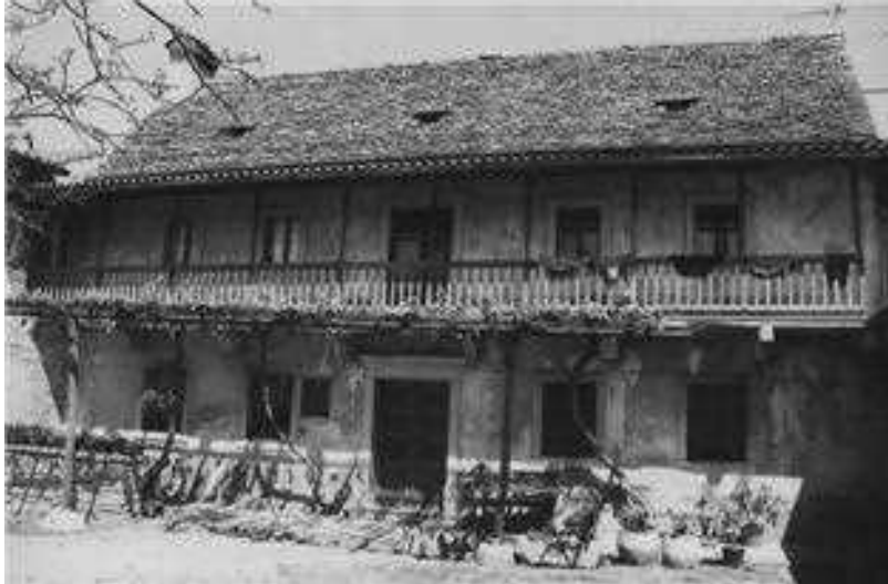
Slika 45 Hiša Urbaníčevih na Filipčjem Brdu z najmlajšo datirano skrilnato streho na Krasu iz leta 1865.
