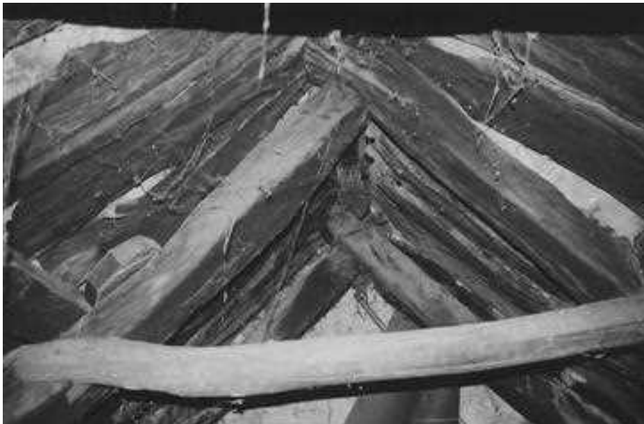
Slika 11 Redka oblika ostrešja iz goltniških povezij z zgoraj prekrižanimi pari škarnikov, slemensko lego in vmesnima gornjima legama v nekdanji zidnici pri Vččkovih, zdaj pri Felpinovih v Povirju.
