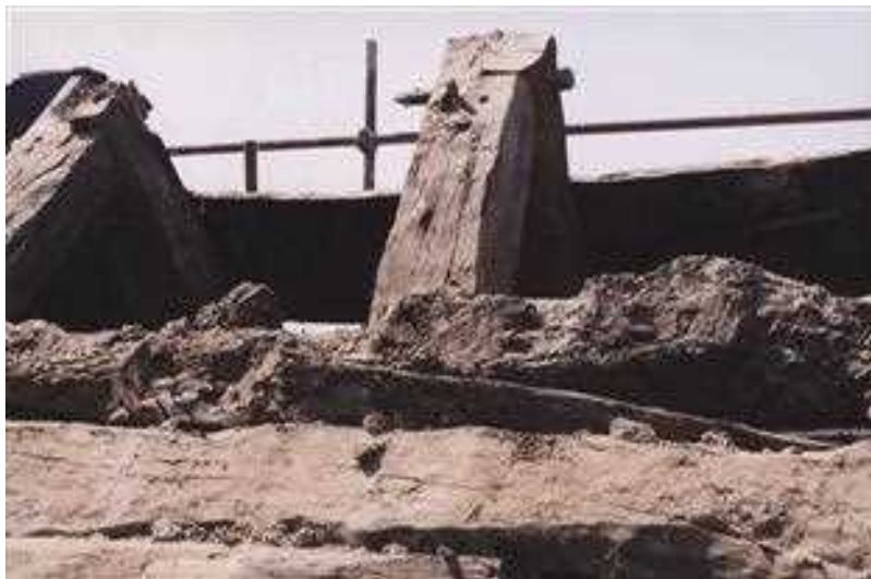
Slika 10 Slamčev skedenj v Pliskovici: škarnika, zvezana z vogalnim preklompom in zbita z lesenim klinom. Foto Viljem Perčič.
