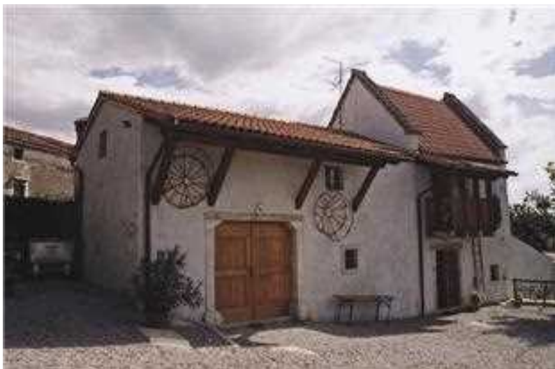
Slika 55 Skedenj v sklopu spomeniško zavarovane Slamčeve domačije v Pliskovici z obešenimi korci na ugreznjeni strehi med skrilnatima zatrepoma.
