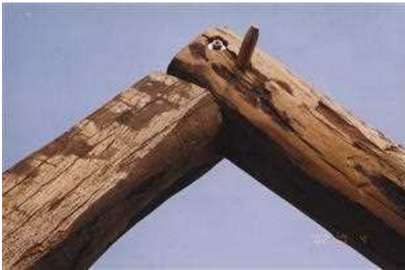
Slika 72 Detajl zveze dveh škarnikov z lesenim klinom in utopljenim kovinskim vijakom na obnovljenem ostrešju Slamčevega skednja v Pliskovici (foto Viliem Perčič, Sežana).
