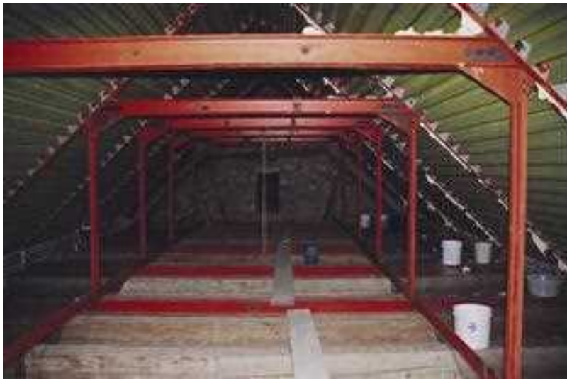
Slika 68 Cerkev Marijinega vnebovzetja na Repentabru: nova jeklena strešna konstrukcija iz povezij s trapeznimi vešali in trapezne pločevine.
