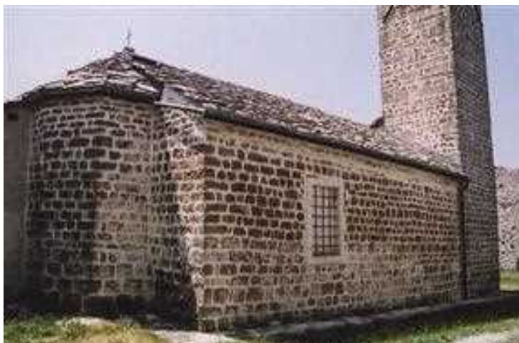
Slika 58 Cerkev Sv. trojice v Hrastovljah z rekonstruirano skrlnato streho.
