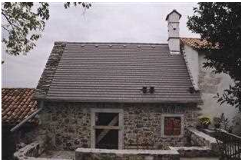
Slika 54 V letu 2005 obnovljen Tinčetov skedenj: dvokapno streho so pokrili s sivim ravno rezanim bobrovcem, na zatrepu pa so rekonstruirali skrilnato strešico.
