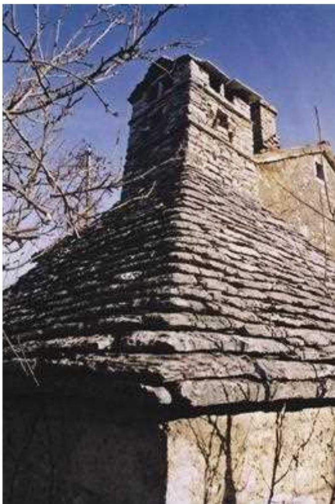
Slika 32 Grebenjaki z dvema daljšima čeloma in polovični grebenjaki z daljšim in krajšim čelom v pravokotnem grebenu šotoraste strehe na spahnjenici Kavalinovih v Povirju.
