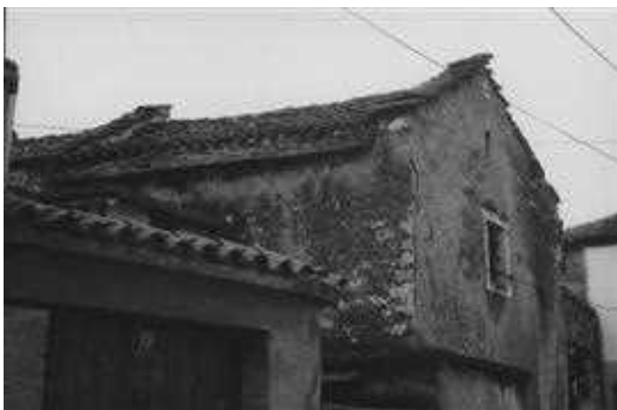
Slika 47 Domačija Ivanovih v Merčah s korci na položni dvokapni strehi in skrili na kapu in na povišanih položnih zatrepnih zidih. V vrhu zatepa ima v omet vrezano letnico 1825.
