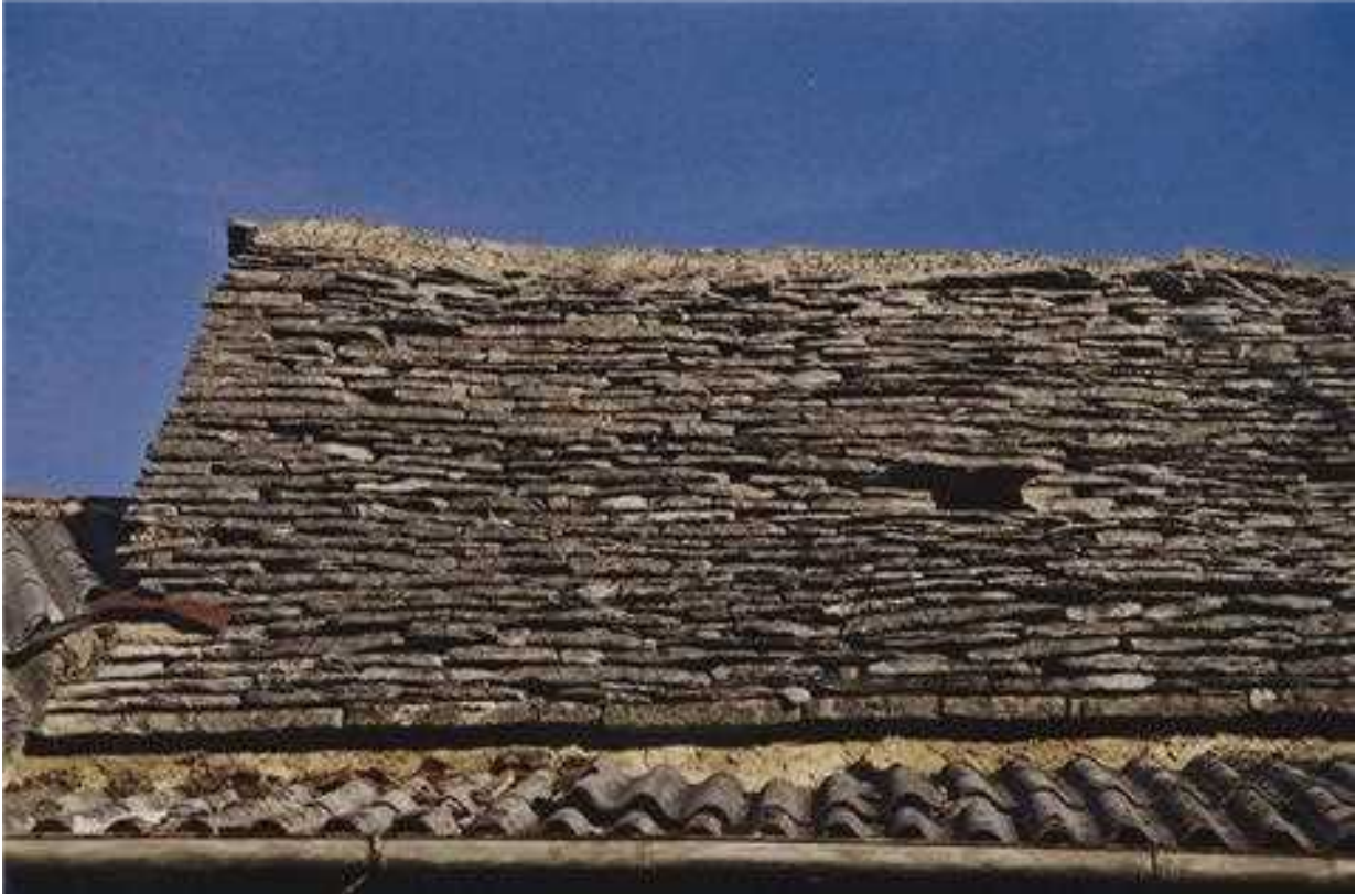
Slika 59 Ometano zidano sleme na skrilnati strehi Jerinovich v Šepuljah.
