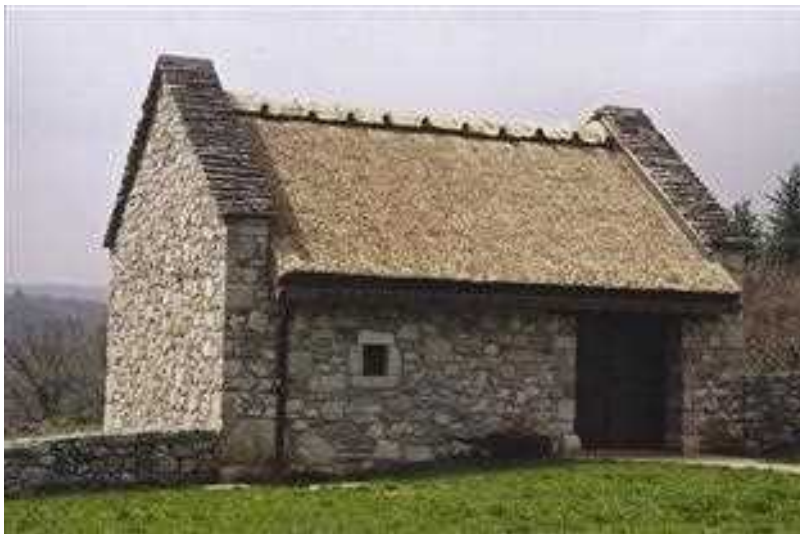
Slika 2 Jakopinov skedenj v Škocjanu, krit s slamo in skrili na zatrepih, prenovljen od temeljev do vrha strehe. Kombinacija slame na strehi in skrila, ki so samo na zatrepih, ne pa tudi na kapih, pomeni prehodno obliko med Krasom in Brkini, kjer so bile številne hiše v celoti krite s slamo.
