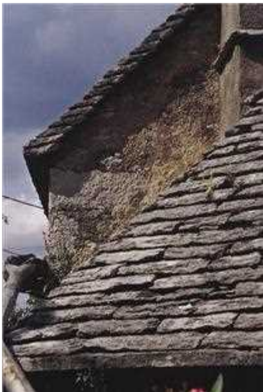
Slika 26 Levi del zatrepnega venca stare hiše Blaževih v Goreniah pri Divači.
