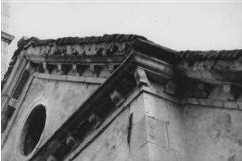
Slika 36 Kamnit venčni zidec pri cerkvi sv. Jurija v Dutovljah, sestavljen iz treh pasov ali nizov: spodnjega gladkega pasu, niza profiliranih konzolic in iz profiliranih masivnih klesanih plošč.
