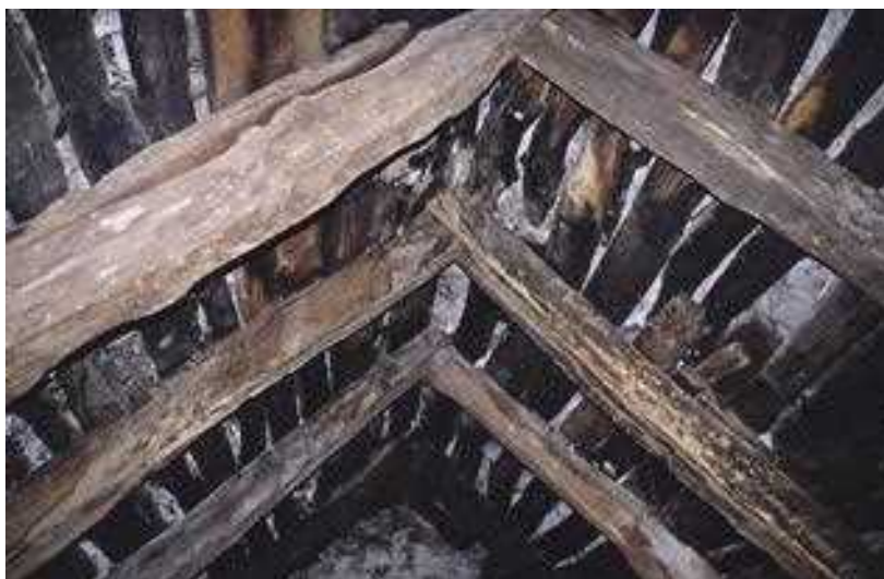
Slika 24 Ostrešje komunske kašče v Šmarjah pri Sežani, v katerem so precejšnji razmiki med krajniki pokriti s podložnimi skrilami.
