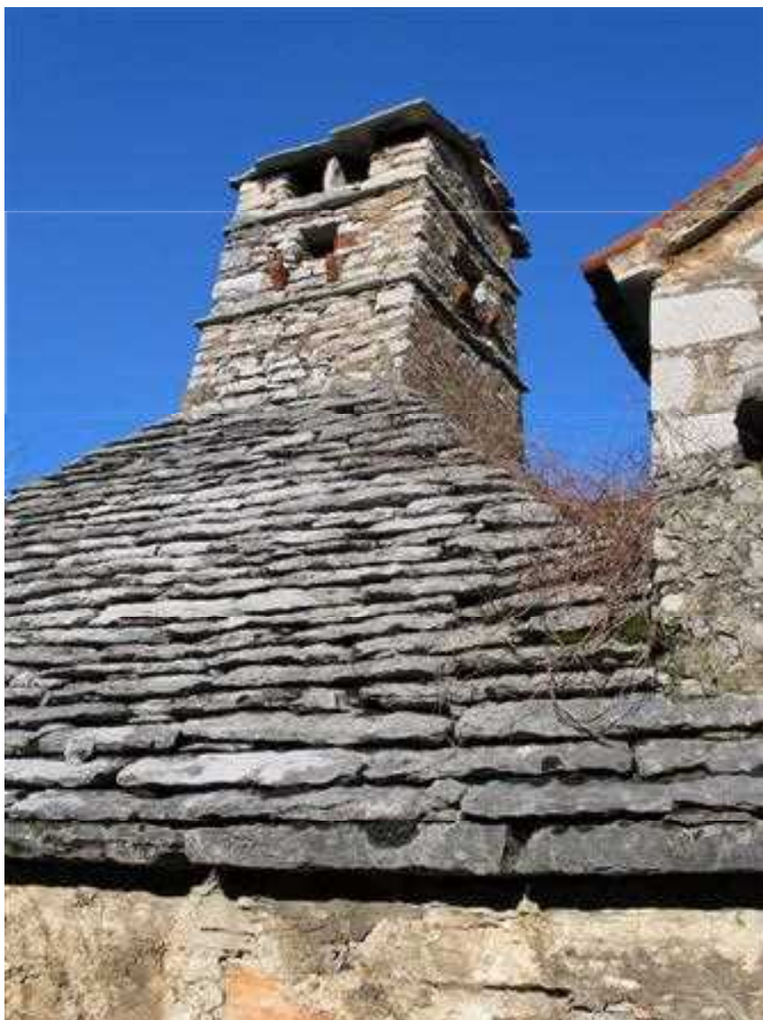
Slika 77 Na strehi z nedotaknjeno prvotno kritino v stikih med plastmi skrila ni videti malte (foto: Mateja Kavčič).
