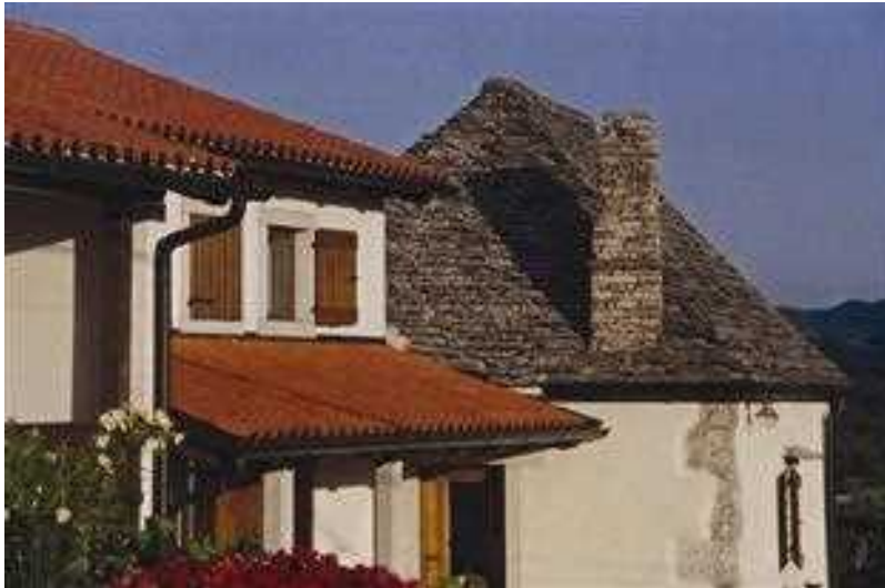
Slika 41 Dimnik na skrilnati strehi hiše pri Gornjih Starčih v Križu pri Sežani.
