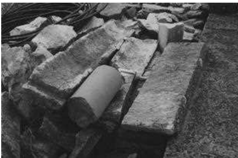
Slika 34 Deponija kamnja v Podnanosu: špičeni masivni slemenjaki pravokotnega prereza z žlebasto spodnjo stranjo in z ravnim preklopom na brazdo.
