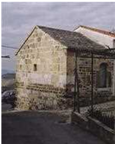
Slika 57 Zatrepana in hrbtna stran Benkove hiše v Črnem Kalu z rekonstruirano skrlnato streho. V latinskem napisu na portalu je datirana z letnico 1489.
