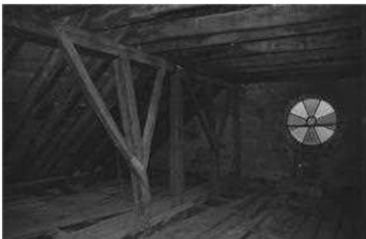
Slika 15 V cerkvi sv. Vida v Podnanosu podpira ostrešje iz goltniških povezij nad ladjo vzdolžna konstrukcija, ki jo sestavljajo spodnja in gornja lega ter stebri z ročicami ali brez njih.
