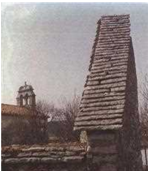
Slika 28 Na zvišanem zatrepu gospodarskega poslopja v Povirju na Krasu, ki je imelo slamnato streho, se v plasteh izmenjujejo široke (cele) in ožje (polovične) venčne skrile (foto: Franc Škrinjar, Povir, ok. 1974).
