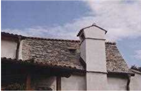
Slika 60 Na obnovljeni strehi sedanjega mladinskega doma v Pliskovici so deli strešine zatesnjeni z malto. – Na slemenu pa so obnovili nekdanjo zasilno rešitev s korci, namesto da bi strehi vrnili prvotno kamnito sleme.
