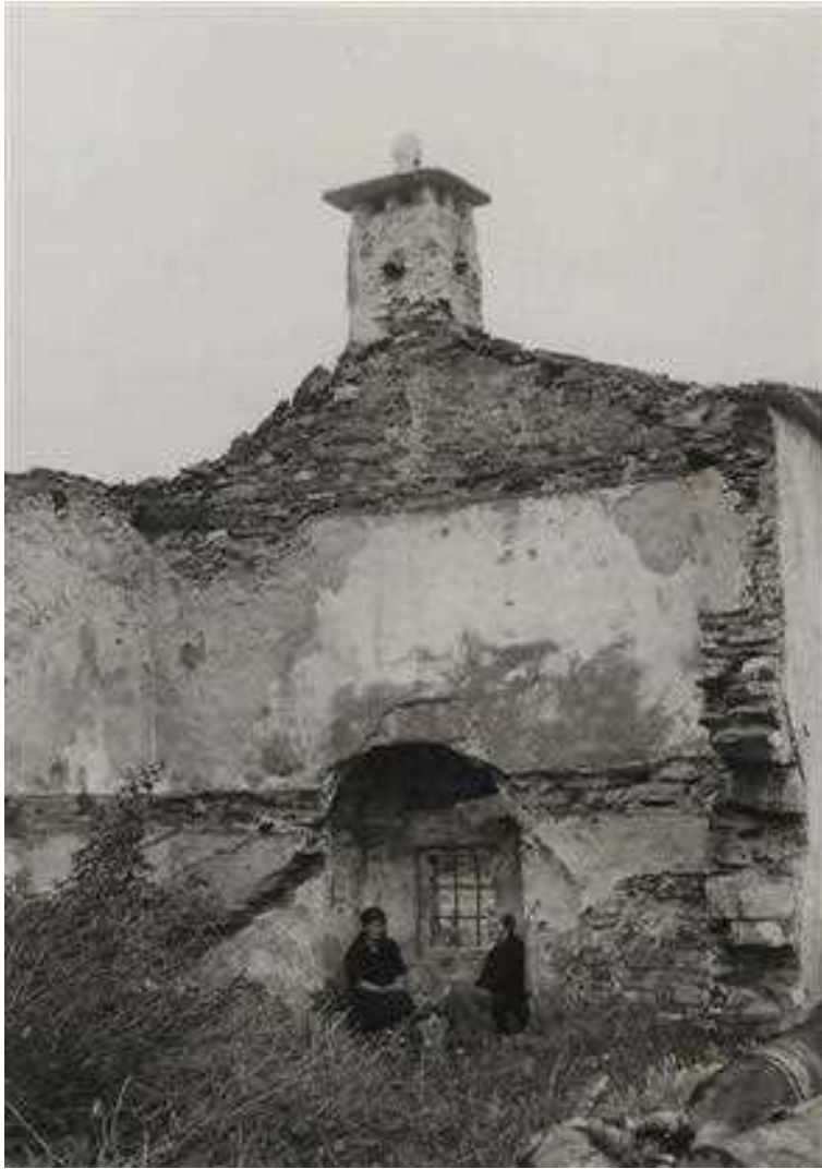
Slika 35 Izjemen dimnik s krovno ploščo in kamnito glavo na njej, ki je bil na nekdanji hiši Špecárjevih v Hraščah pri Podnanosu.
