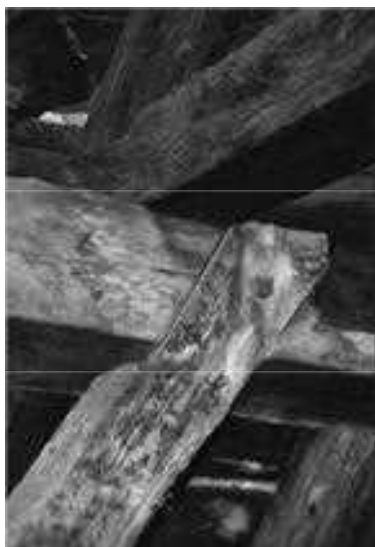
Slika 19 Cerkev sv. Vida v Podnanosu: zveza ročice in gornje lege s sklopom na polovični lastovičji rep.
