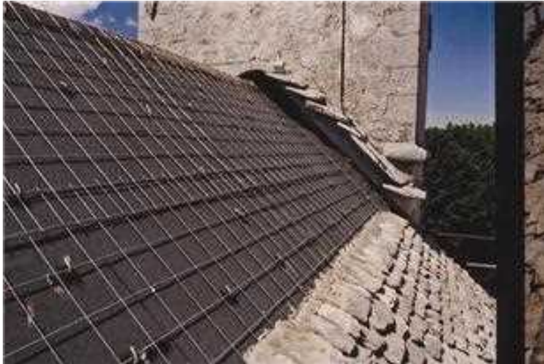
Slika 69 Cerkev Marijinega vnebovzvetja na Repentabru: pokrivanje strehe na izredno močno armirano sekundarno kritino.
