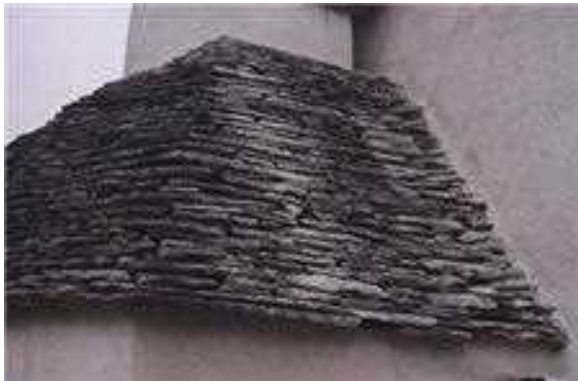
Slika 22 Tanjše skrole brez poševno posnetih čel na strehi spahnjenice Venckovih v Matavunu.
