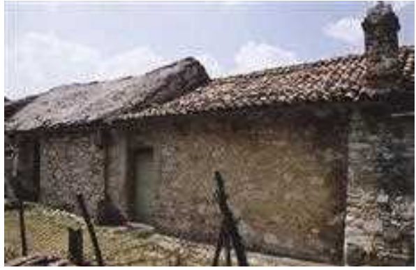
Slika 61 Na stavbi v gornjem delu Štanjela je cela streha zalita s cemento malto.
