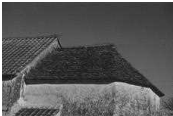
Slika 51 Cerkev sv. Lovrenca v Kazljah: na ladji in zakristiji so skrlnato kritino zasilno nadomestili z malimi salonitnimi ploščami.
