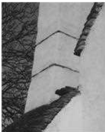
Slika 43 Pomolno položena globel (žlota) iz klesanega kamna na strehi kotne spahnjenice pri Škrateljnovi hiši v Divači.
