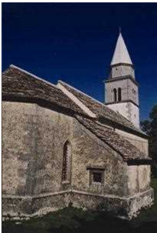
Slika 66 Cerkev sv. Križa v Križu pri Sežani z obnovljenimi strehami. - Pri tem niso ustrezno obnovili in prilagodili odpadlega ometa pod kapom zakristije.
