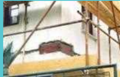
Povezovanje in sidranje jeklenih vezi z jeklenimi sidrnimi ploščami. Vir: Arhiv GI ZRMK
