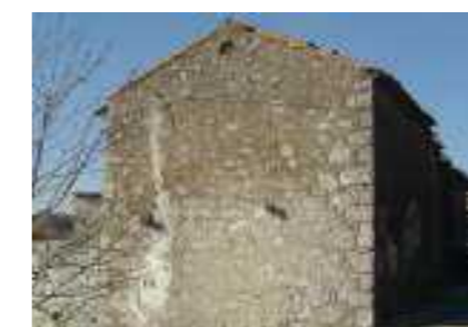
Manj pomembne fasade so bile grobo ometane le s tankim slojem ometa • Avtor fotografije: Nataša Kolen
