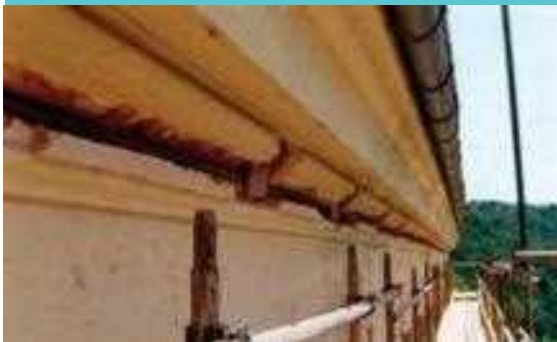
Vgradnja jeklne vezi pod napuščem. Vir: Arhiv GI ZRMK
