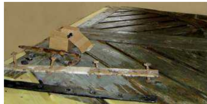
Enaka pozornost kot lesnim delom, je bila posvečena tudi obnovi okovja in drugih kovinskih elementov, ki so pogosto oblikovno zelo zanimivi, še vedno uporabni, a kljub temu zavrženi. Dela pri obnovi kovinskih delov je opravil mojster kovač. Avtor fotografije: Nataša Kolenc
