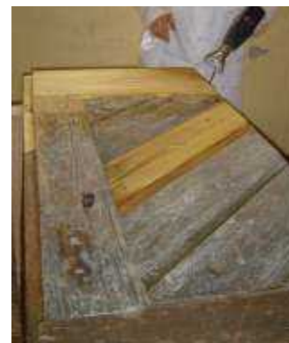
Vrata, ki so bila v spodnjem delu povsem propadla, so bila obnovljena tako, da so najbolj poškodovane dele izrezali in nadomestili z novimi, na preostalih površinah pa so bila izvedena le lokalna popravila. Na koncu so bila vrata na novo impregnirana, površinsko obdelana in vgrajena na nekdanje mesto • Avtor fotografije: Nataša Kolenc
