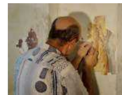
V notranjosti Lanthierjevega dvorca so slikopleskarji opravili sondiranja beležev in odkrili stenske poslikave v fresko tehniki. Preizkusili so se tudi v izvedbi novih dekorativnih poslikav. Vir: Arhiv OCRA Obrtni center restavratorstva d.o.o.
