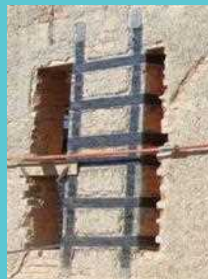
Ojačitev stropa med odprtinama s karbonskimi trakovi. Avtor fotografije: Mojca Jarc Simonič
