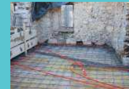
Izvedba nadomestne polne AB plošče. Vir: Arhiv Graditeljstvo Henigman d.o.o.
