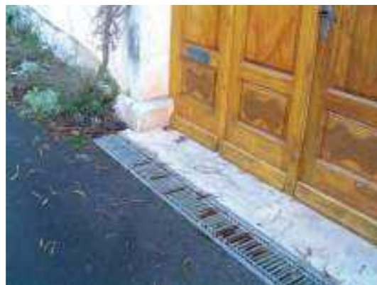
Odtočna rešetka preprečuje zlivanje vode z ulice v notranjost objekta. Avtor fotografije: Nataša Kolenc
