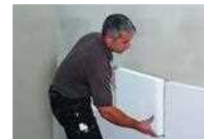
Izvedba notranje izolacije s ploščami kalcijevega silikata.
