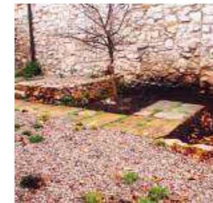
Umeščanje cistern, zadrževalnikov in zbiralnikov ter zasajanje okrog njih. Vir: Pepa s Krasa • Avtor fotografije: Borut Benedejčič
