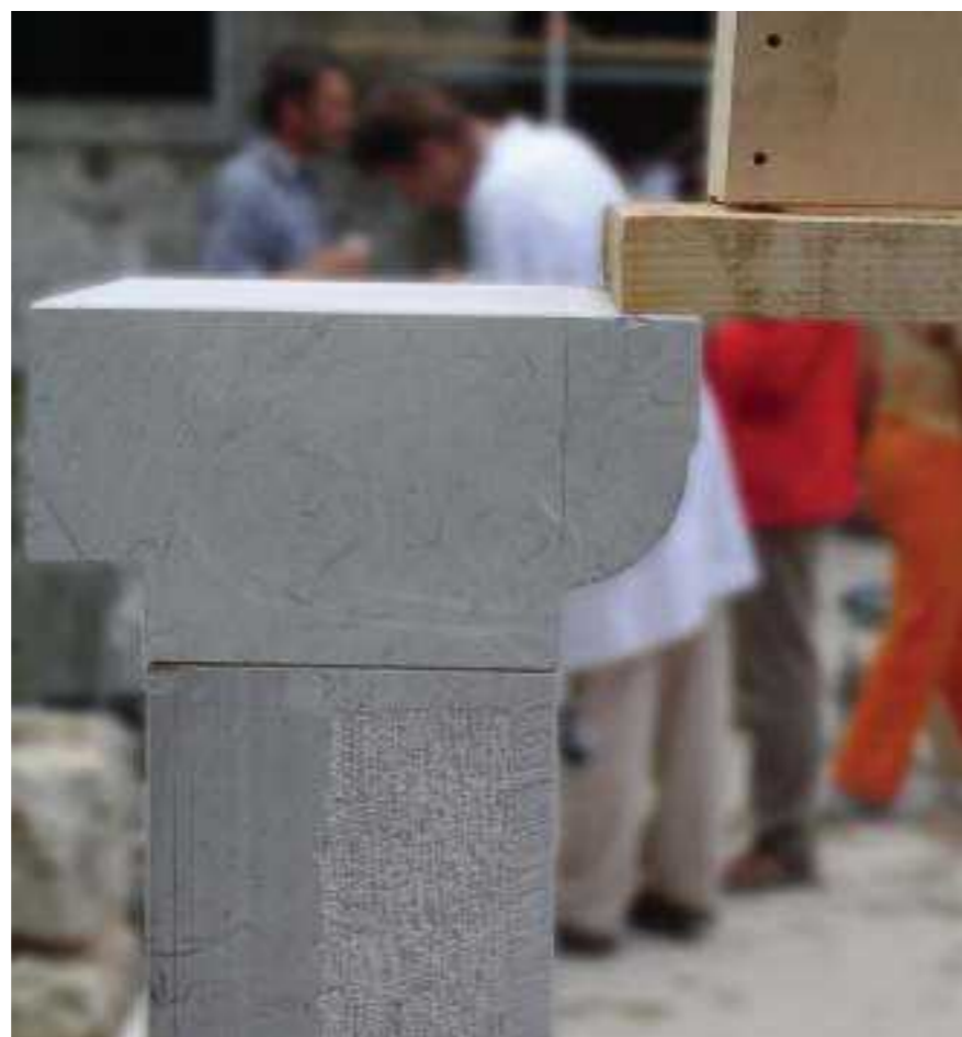
Vzidava novih kamnitih elementov in pozidava v preteklosti porušenega zidu z apneno malto za zidanje. Avtor fotografije: Nataša Kolenc
