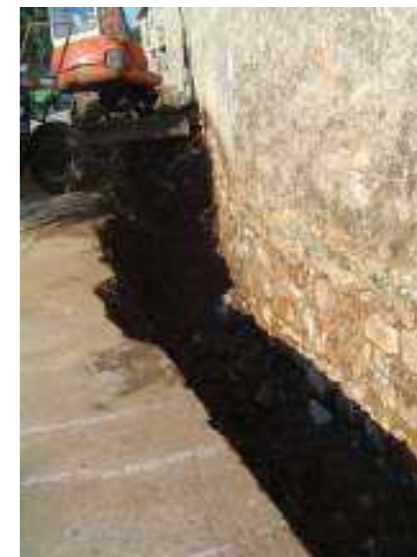
Prikaz izkopa za izvedbo drenaže objekta, ki je na cestni strani vkopan za celo etažo. Avtor fotografije: Nataša Kolenc
