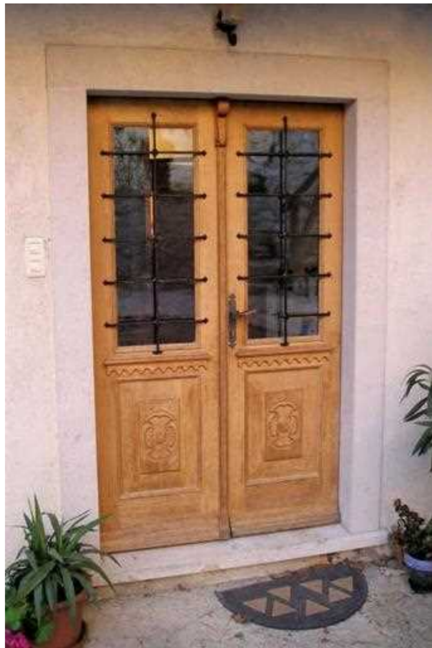
Štanjel - v celoti na novo izdelana vhodna vrata, ki so dober primer kako nadomestiti manjkajoča ali preveč poškodovana stara vrata. Vir: Arhiv OCRA Obrtni center restavradorstva d.o.o.
