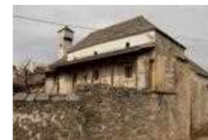
Prenovljena streha, krita s skrlami. Avtor fotografije: Bogdan Zupan
