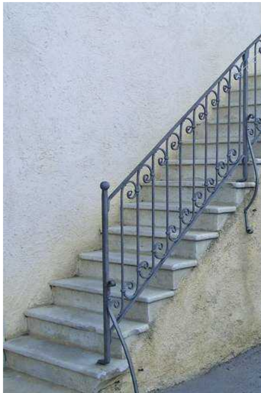
Gabrje - obnovljeno zunanje kamnito stopnišče. Vir: Arhiv OCRA Obrtni center restavradorstva d.o.o.
