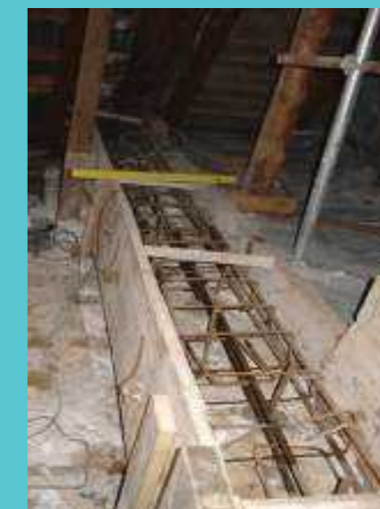
Izvedba AB okvirja • Vir: Arhiv GI ZRMK
