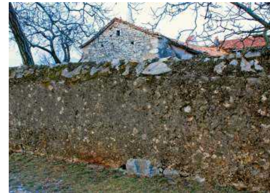
Največkrat so stranice zidu ometali z apnenim ometom • Vir: Pepa s Krasa • Avtor fotografije: Borut Benedejčič
