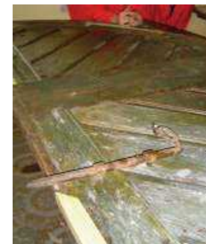
Vrata, ki so bila v spodnjem delu povsem propadla, so bila obnovljena tako, da so najbolj poškodovane dele izrezali in nadomestili z novimi, na preostalih površinah pa so bila izvedena le lokalna popravila. Na koncu so bila vrata na novo impregnirana, površinsko obdelana in vgrajena na nekdanje mesto • Avtor fotografije: Nataša Kolenc
