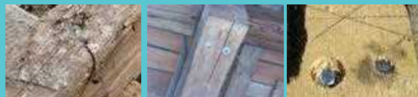
Z navojnimi palicami povezani elementi ostrešja • Vir: Vpliv obremenitev z vetrom na ostrešja: T. Pazlar, J. Srpčič, 2009
