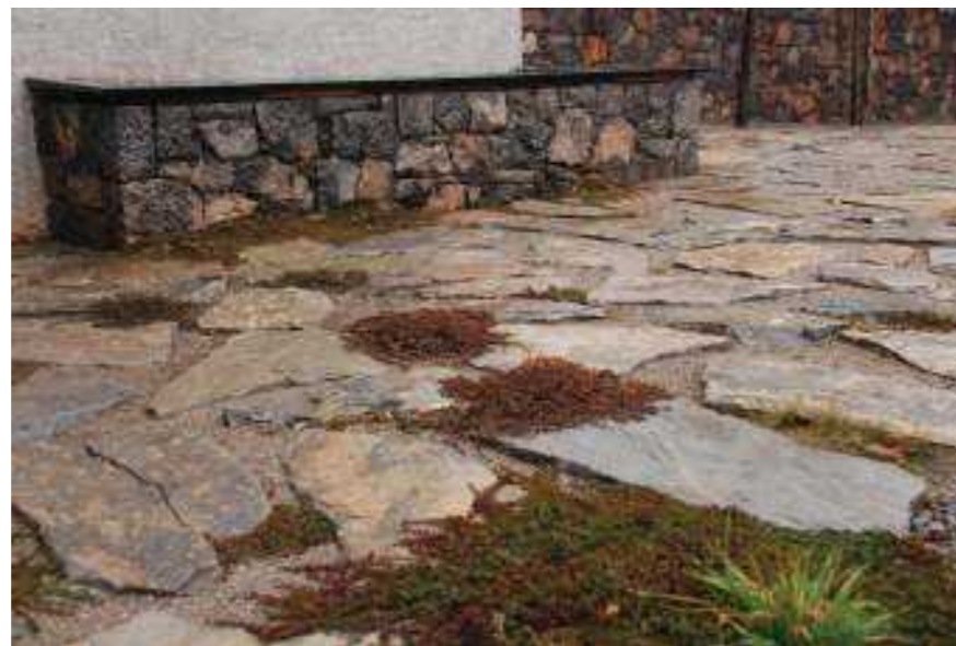
Tlakovanje za namene parkirišča – prana betonska plošča iz drobljenca • Vir: Pepa s Krasa Avtor fotografije: Borut Benedejčič
