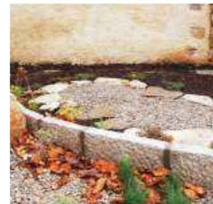
Pravilno umeščanje čistilne naprave in hortikulturno zastiranje vidnih delov. Vir: Pepa s Krasa • Avtor fotografije: Borut Benedejčič
