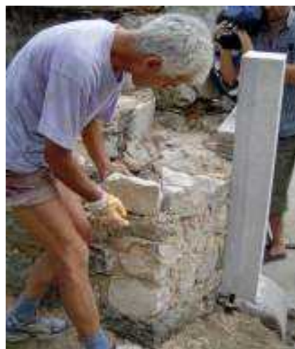
Vzidava novih kamnitih elementov in pozidava v preteklosti porušenega zidu z apneno malto za zidanje. Avtor fotografije: Nataša Kolenc
