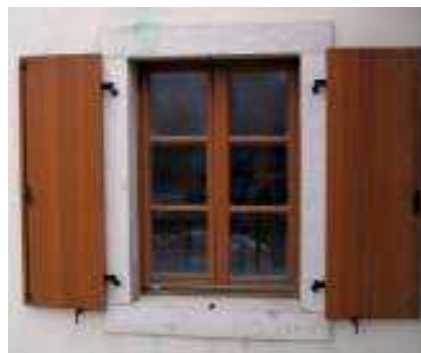
Klanec pri Kozini - polkna in okenska krila so izdelana kot replika originala in delujejo skladno. Vir: Arhiv OCRA Obrtni center restavradorstva d.o.o.
