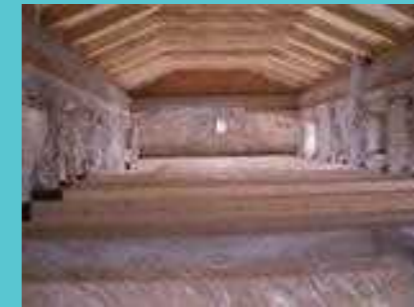
Utrditev zatrepne stene z izvedbo horizontalne vezi in pozidavo »trikotnika« na novo. Avtor fotografije: Dario Grilanc
