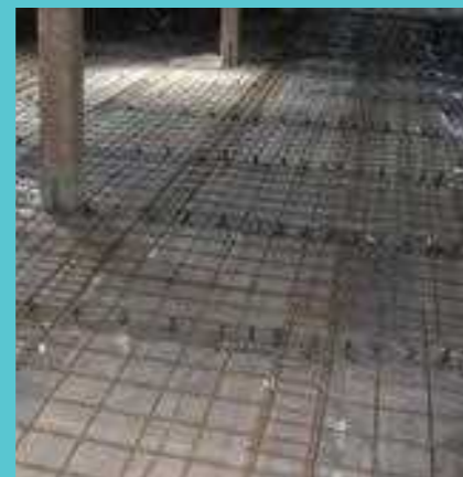
Izvedba sovprežne plošče z uporabo obstoječih stropnikov. Vir: Arhiv GI ZRMK
