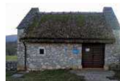
Rekonstrukcija slamnate kritine. Avtor fotografije: Stanko Vitez
