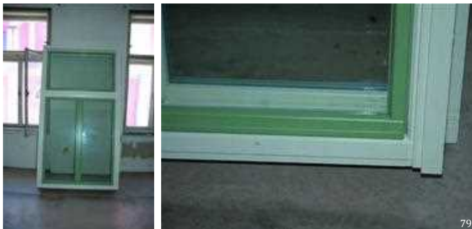
(79) Pri menjavi večjega števila oken je priporočljivo pred izdelavo vseh oken v celoti izvesti vzorčno okno.
