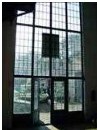
(72) Okna, značilna za industrijsko arhitekturo – kovinska in različne oblike zasteklitve stavb, zgrajenih v drugi polovici 20. stoletja.
