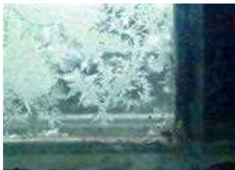
(5) Ledene rože na okenski šipi zaradi zamrznitve kondenzata pri zelo nizkih temperaturah.
