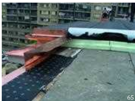
(64) Hidroizolacija ravne strehe z bitumenskimi varilnimi trakovi.
