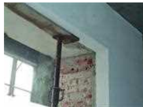
(44) Vgradnja kapilarno aktivne toplotne zaščite na notranjo stran zunanje stene.
