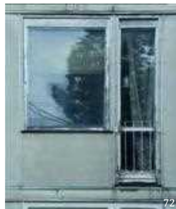
(72) Okna, značilna za industrijsko arhitekturo – kovinska in različne oblike zasteklitve stavb, zgrajenih v drugi polovici 20. stoletja.
