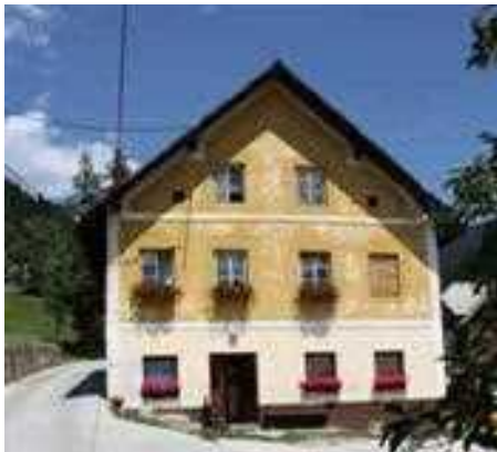
Slika/Abbildung 38: Simetrično razporejeno stavbno pohištvo skladnih velikosti / Symmetrisch angeordnete Fenster einheitlicher Größe (Rateče)
