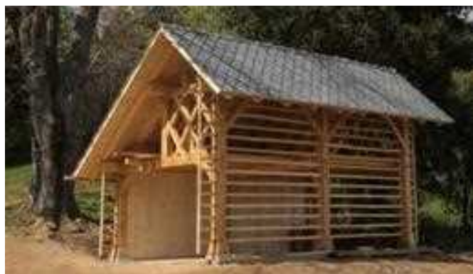
Slika/Abbildung 96: Cementni špičak je kakovostna in estetska kritina, ki se je v preteklem stoletju v naših krajih močno uveljavila in jo uporabljamo še danes. / Zementziegel sind eine qualitätsvolle und ästhetische Dachdeckung, welche sich im vergangenen Jahrhundert in unseren Gebieten stark durchgesetzt haben und die wir heute noch anwenden.
