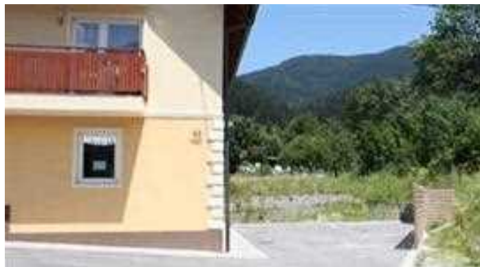
Slika/Abbildung 73: V ometu izveden šivan vogal na sodobnem objektu / Im Putz ausgeführte genähte Ecken am modernen Objekt
