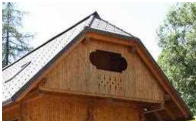
Slika/Abbildung 32: Zatrejni gank na novo zgrajenem objektu / Giebelgank auf neu erbautem Objekt (Rateče)
