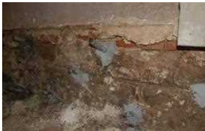
Slika/Abbildung 90: Utrditev obstoječega temelja z injektiranjem / Festigung des bestehenden Fundamentes mit Injektion
