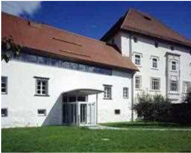
Slika/Abbildung 104: Vrtec - nežen okenski niz in markanten vhod krasita trakt s prostori vrtca. / Kindergarten. Zarte Fensterbänder und eine markante Eingangstüre prägen die alte Fassade des jetzigen Kindergartentraktes.
