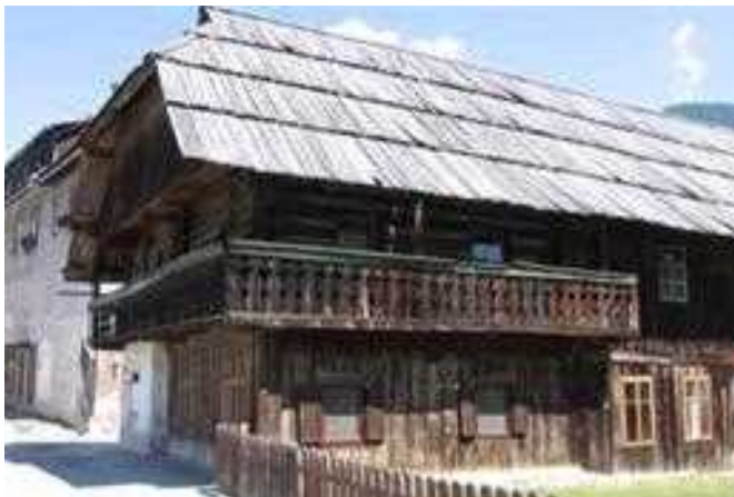
Slika/Abbildung 17: Hiša z delno iz kamna zidanim, delno lesenim pritličjem in nadstropjem, zgrajenim iz brun / Haus teils aus Stein gebautem, teils aus Holz gebautem Erdgeschoss und Obergeschoss, Blockbauweise (Kranjska Gora)
