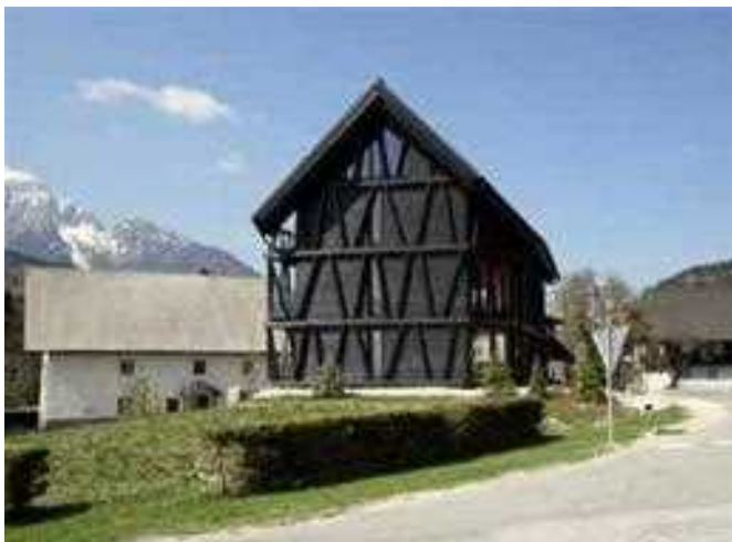
Slika/Abbildung 86: Družinska hiša v Ratečah. Počasi se tudi v perifernih predelih porajajo ideje za stanovanjske objekte, ki na sodoben način uporabljajo tradicionalno gradbeno znanje. / Einfamilienhaus in Rateče. Langsam entstehen auch in peripheren Regionen besondere Lösungen für Eigenheime, die traditionelle Bauweisen versuchen zeitgenössisch anzuwenden.
