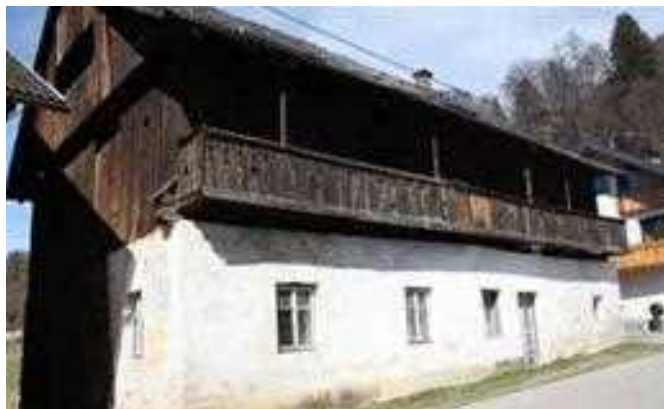
Slika/Abbildung 30: Gank, ki poteka vzporedno z daljšo stranico hiše in je pomaknjen pod napušč / Sogenannter „Gank“, der parallel zur längeren Hausseite verläuft und unter das Dachgesims gerückt ist (Čajna - Nötsch)
