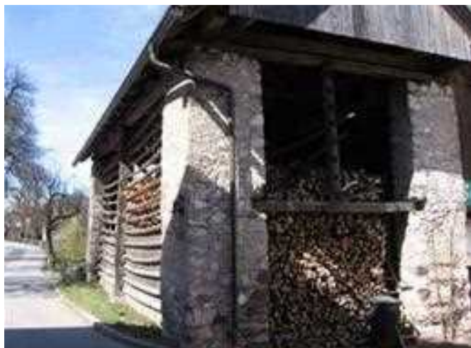
Slika/Abbildung 62: Kozolec z zidanimi stebri brez bogatih okrasnih detajlov / Harpfen mit gemauerten Säulen ohne reich dekorierte Details (Čajna - Nötsch)
