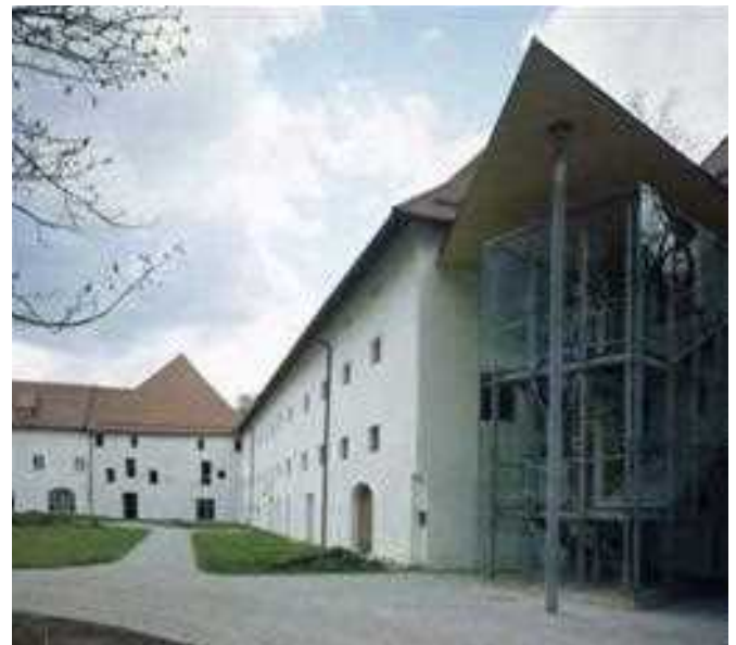
Slika/Abbildung 105: Ustvarjalni prostor v starem zidovju - zastekljen stolp s stopniščem vodi do risalnic v severnem traktu. / Stiegenaufgang Tagesheim – Marienhof. Ein kreativer Ort in alten Gemäuern – der verglaste Stiegenturm führt zu den Zeichenräumen im Nordtrakt.
