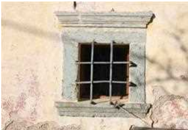
Slika/Abbildung 97: Kamniti okenski okviri iz zelenega peščenjaka, tufo, so značilni za območje Karavank in dajejo arhitekturi značilen pečat. / Steinfensterrahmen, aus grünem Sandstein, Tufo, sind charakteristisch für das Gebiet der Karawanken und verleihen der Architektur ein Gütesiegel.
