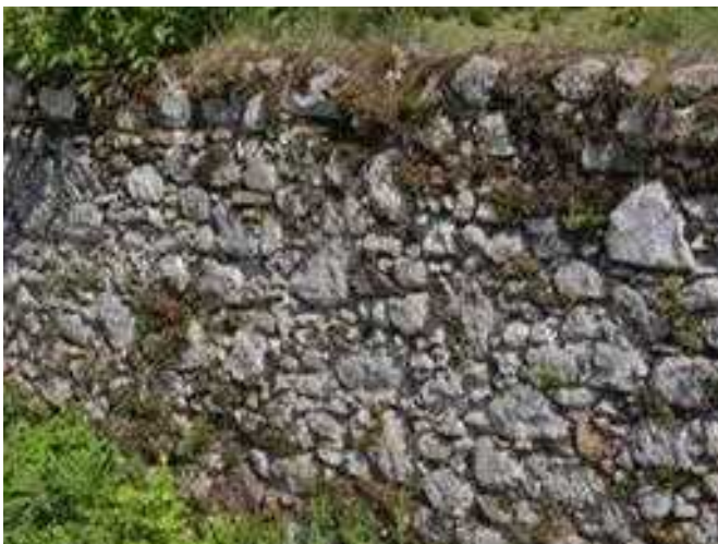
Slika/Abbildung 66: Tradicionalna kamnita škarpa, zložena iz kamenja različnih velikosti / Traditionelle Stützmauer aus Stein, geschichtet aus Steinen verschiedener Größen (Begunje na Gorenjskem)
