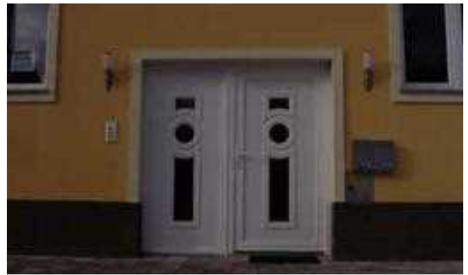
Slika/Abbildung 43: Vrata, ki po svoji izvedbi povsem spominjajo na mestno večstanovanjsko gradnjo / Tür, welche nach ihrer Ausführung vollkommen an ein stattliches Mehrparteienhaus erinnert
