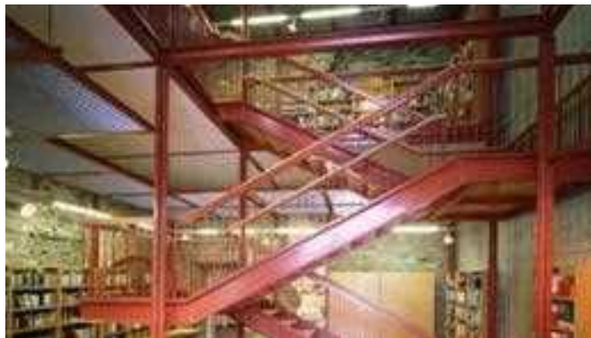
Slika/Abbildung 99: Šolska knjižnica. Stolp iz rdečega jekla zapolnjuje prostor med zgodovinskimi kamnitimi zidovi. / Schulbibliothek. Der maßgefertigte Bibliotheksturm aus rotem Stahl füllt den Raum zwischen den historischen Steinmauern.
