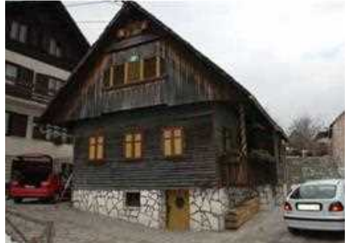
Slika/Abbildung 24: Talni zidec je obložen s sodobno oblogo, ki posnema nekdanjo kamnito gradnjo, vendar za območje Karavank ni značilna. / Der Sockel wurde mit einem modernen Belag versehen, der den einstigen Steinbau nachahmt, jedoch für das Karawankengebiet untypisch ist.
