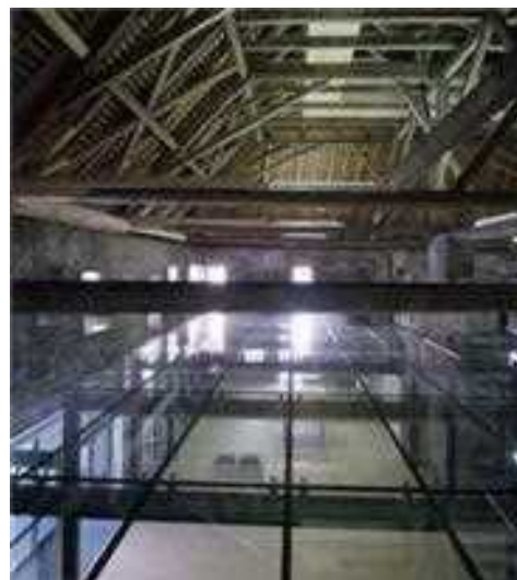
Slika/Abbildung 101: Učilnice za tehnično vzgojo - arhitekt Gernot Kulterer je za oblikovanje keramike predvidel prostore s steklenimi stenami in stropi, ki nudijo edinstven pogled na obrambne zidove in veličastno zgodnjebaročno ostrešje. / Unterrichtsräume Werkerziehung. Architekt Gernot Kulterer versah die Keramikwerkstätten mit verglasten Wänden und Decken, die eine einmalige Sicht auf die Wehranlage und den imposanten frühbarocken Dachstuhl bieten.
