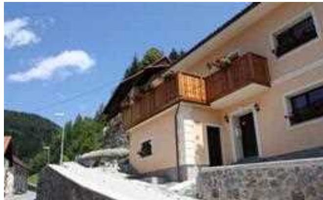
Slika/Abbildung 31: Balkon, ki ga napušč ne pokriva in ki se lomi, da objame še teraso / Balkon, der vom Dachgesims nicht überdeckt und unterbrochen wird, damit er noch die Terrasse umschließt
