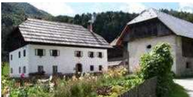
Slika/Abbildung 46: Strehi dvokapnici s čopi / Zwei Satteldächer mit Walmen (Log pri Kranjski Gori)
