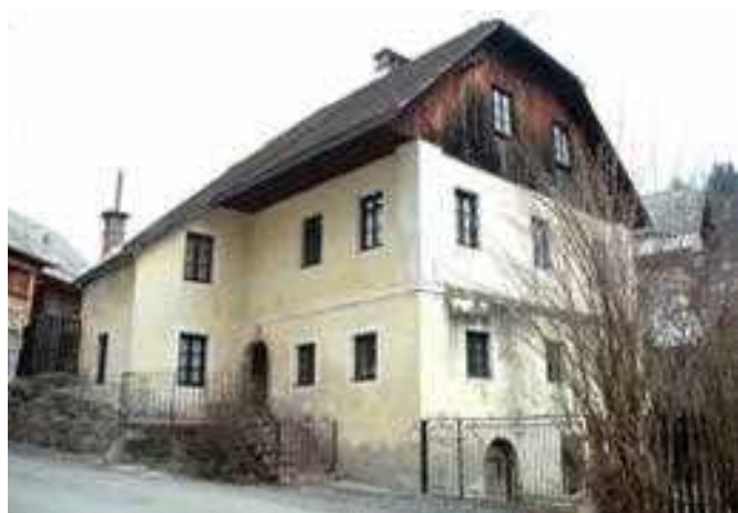
Slika/Abbildung 118: Hiša v Kamni Gorici pred obnovo / Das Haus in Kamna Gorica vor der Renovierung.
