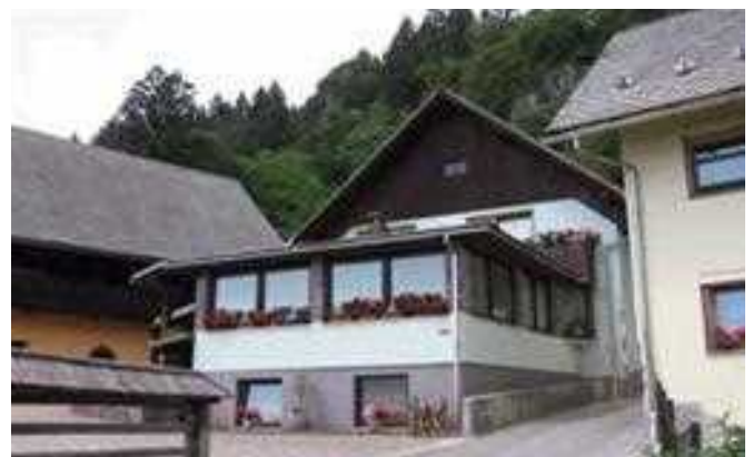
Slika/Abbildung 45: Prizidek z ravno streho / Zubau mit geradem Dach
