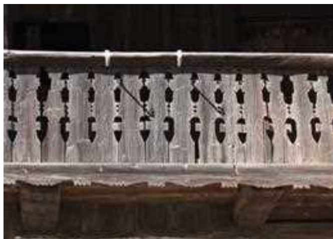
Slika/Abbildung 34: Late so izrezljane, postavljene tesno druga ob drugo, spodaj segajo čez rob pohodne površine / Die Latten sind geschnitzt, dicht aneinander angeordnet, auf der Unterseite reichen sie über den Rand der Lauffläche (Čajna - Nötsch)
