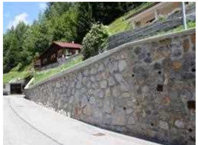
Slika/Abbildung 67: Kamnita škarpa s širokimi fugami med kamni / Stützmauer aus Stein mit breiten Fugen zwischen den Steinen
