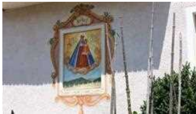
Slika/Abbildung 71: Nova izvedba poslikave na prenovljeni hiši – posnemanje vzorcev, sicer značilnih za starejše stavbe / Neue Ausführung der Bemalung am renovierten Haus – Nachahmung der Muster, welche zwar für ältere Gebäude charakteristisch sind
