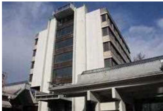
Slika/Abbildung 114: Stavba nekdanjega hotela Transturist je z izgubo funkcionalnih in tehničnih kvalitet značilen objekt, pri katerem ekonomska analiza kaže, da prenova ni več smiselna. / Das Gebäude des einstigen Hotels Transturist ist mit dem Verlust der funktionellen und technischen Qualitäten ein charakteristisches Objekt, bei dem die wirtschaftliche Analyse zeigt, dass eine Renovierung nicht mehr sinnvoll ist.
