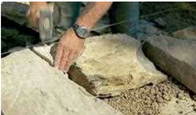
Vstavljanje mnajših kamnov/ Umetanje manjih kamenova
