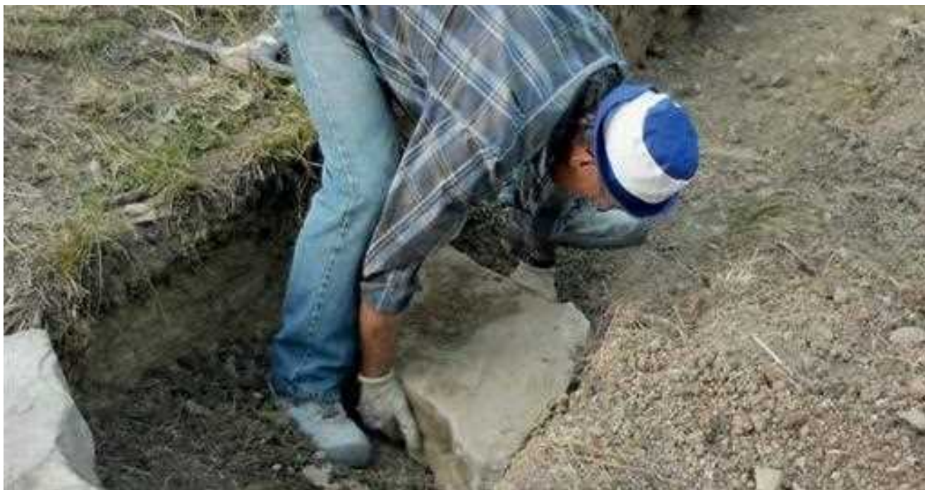
Izdelava pete (temelja) zida/Izrada pete (temelja) zida
