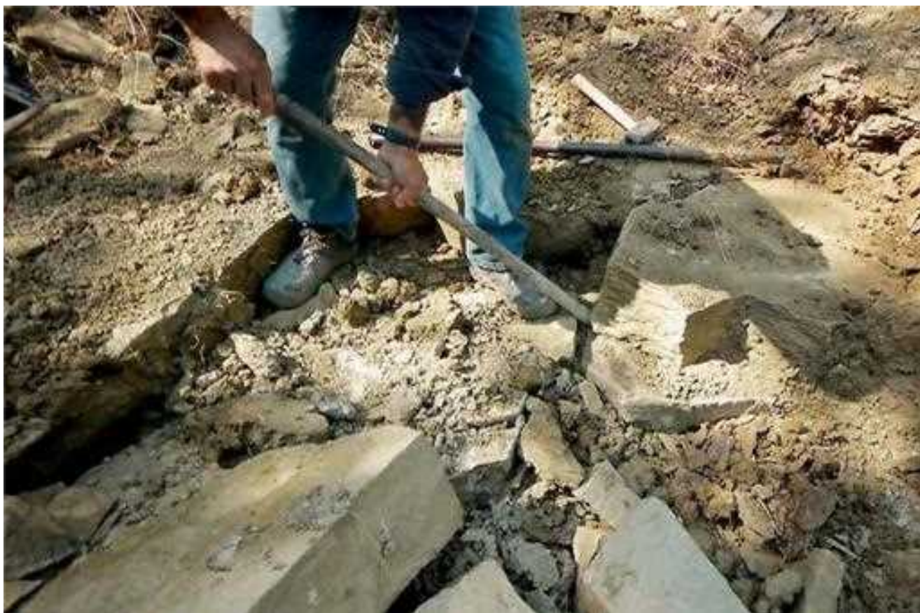
Izkop kamna v »kavi« pri Karlih / Iskop kamena u »kavi« kod Karla
