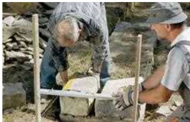
Gradnja vogala/Gradnja ugla
