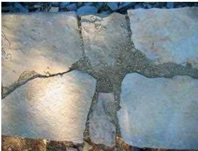
Zgornji zaključek zida, zgrajenega na drugi delavnici v Pisarih/ Gornji završetak zida, izgrađenog na drugoj radionici u Pisarima
