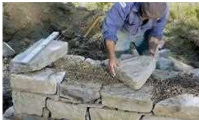
Polaganje robnega kamna/ Postavljanje rubnoga kamena
