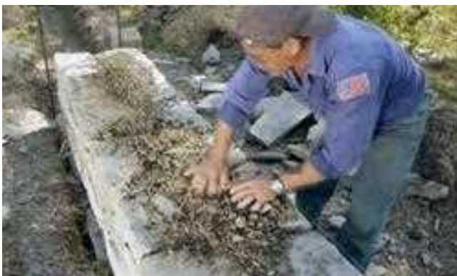
Zapolnjevanje notranjosti zidu z zemljo/ Ispunjavanje unutrašnjosti zida zemljom
