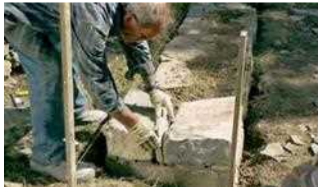
Vstavljanje mnajših kamnov/ Umetanje manjih kamenova
