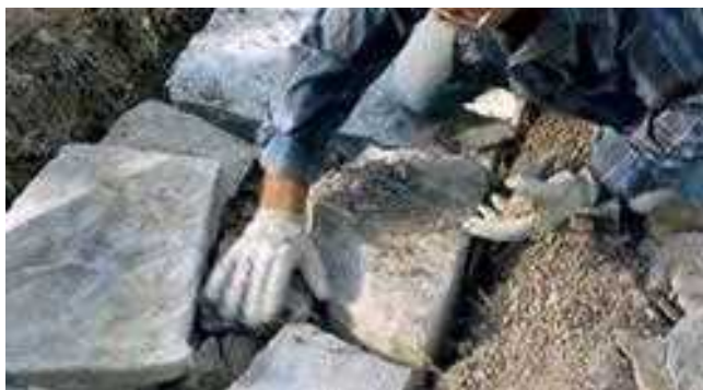
Zapolnjevanje temelja z drobirjem/ Zapunjavanje temelja sipinom
