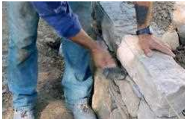
Postavljanje robnega kamna/ Polaganje rubnog kamena
