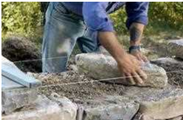
Polaganje veznega kamna/ Polaganje veznog kamena
