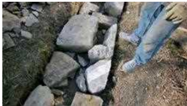
Peta (temelj) zida/ Peta (temelj) zida
