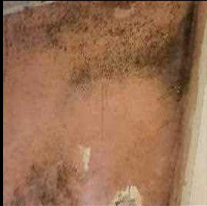
Vzroki so pogosto vezani na način življenja: premalo zračenja, vgradnja fiksnega pohištva, sušenje perila v zaprtih prostorih. Ali vnosu hladnih gradiv: izravnave sten z mavčnim kitom, toplotni mostovi...
